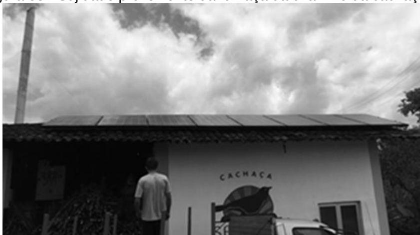
Figura 88 - Sujidade proveniente da fumaça da chaminé da cachaçaria.
