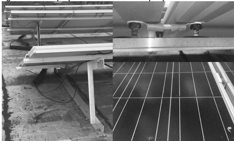
Figura 80 – Inspeção no sistema de captação solar da DMU94
