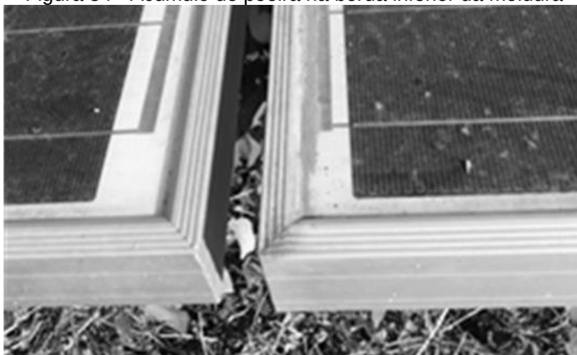
Figura 84 - Acúmulo de poeira na borda inferior da moldura
