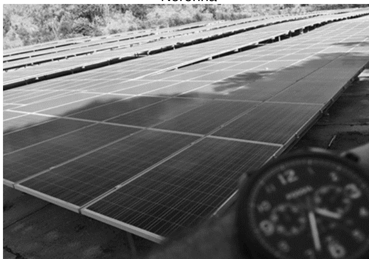
Figura 83 - Sombreamento na DMU-28 em Fernando de Noronha
