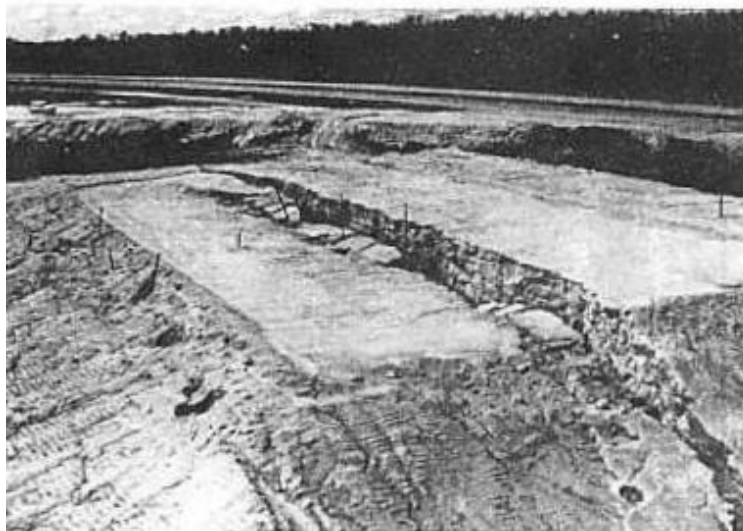
Figura 36 – Ruptura do aterro experimental da Malásia.
