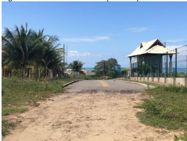
Figura 83 - Mirante do Mar: final da pavimentação
