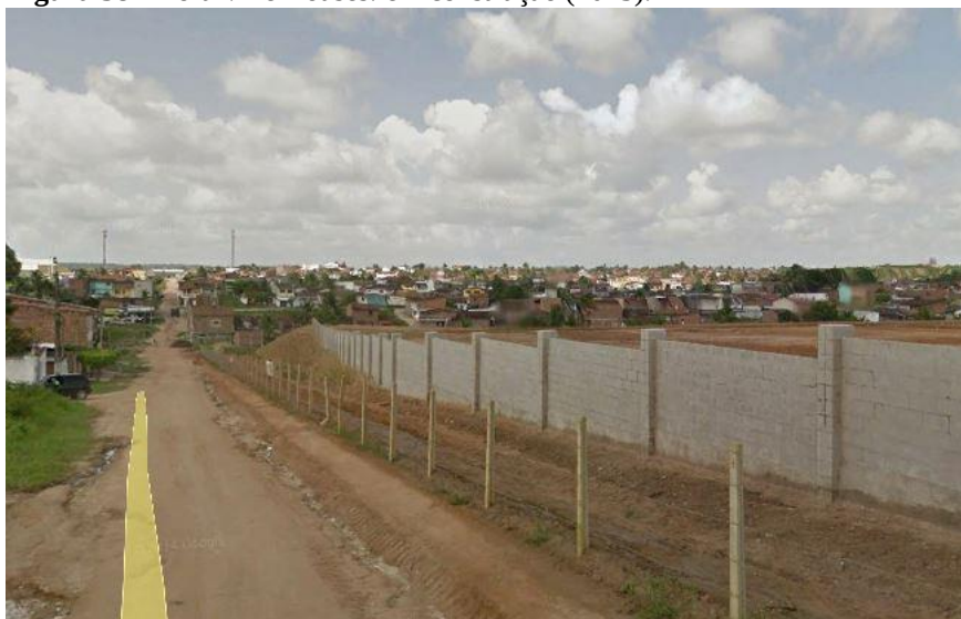
Figura 38 - Northville Houses: em construção (2013).
