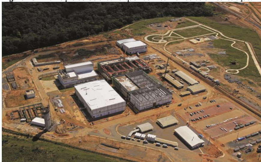
Figura 28 - Município de Goiana: Parque Fabril da Hemobrás em construção.
