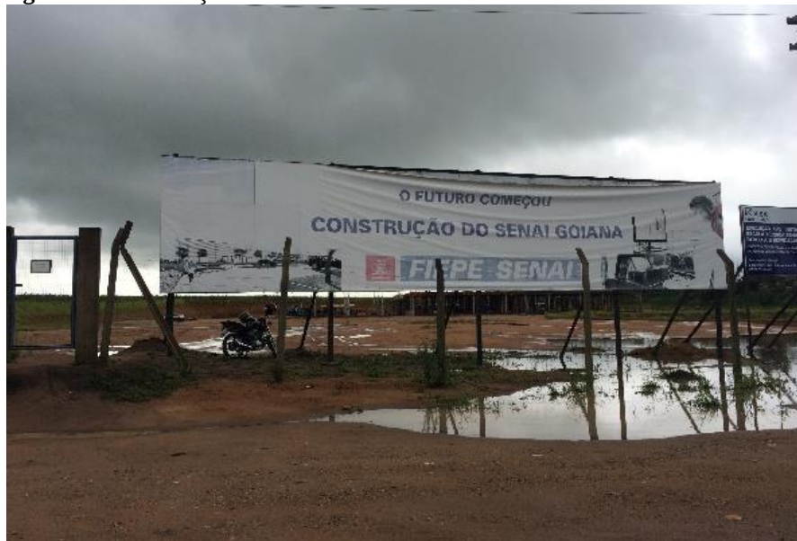
Figura 43 - Construção do SENAI.
