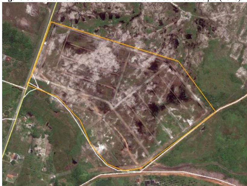
Figura 80 - Loteamento fechado Caminho da Praia: em construção (2010).
