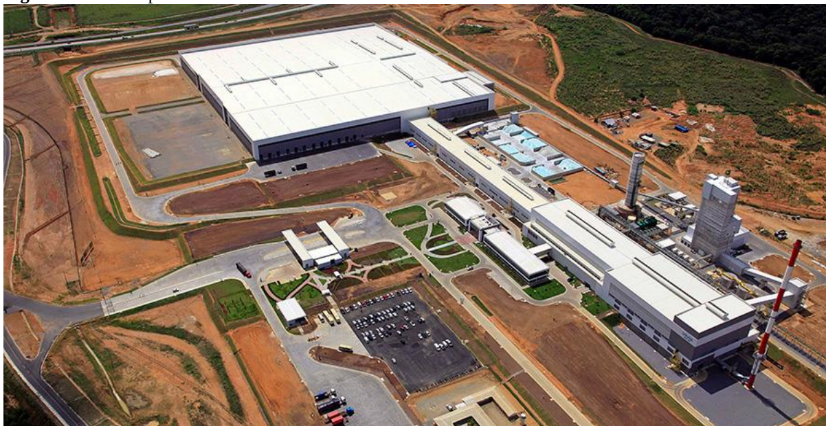
Figura 31 - Município de Goiana: Fábrica da Vivix.
