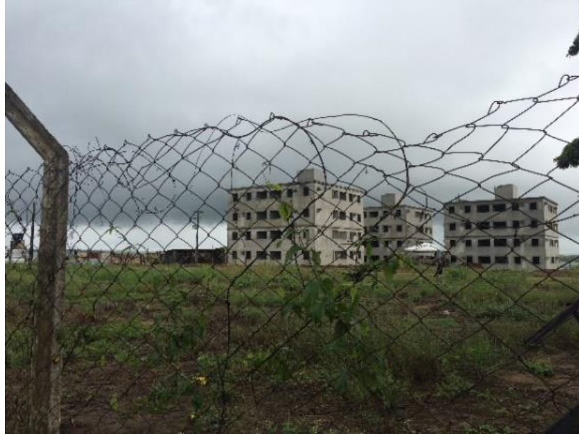
Figura 53 - Portal Goiana Residence: obras em andamento.
