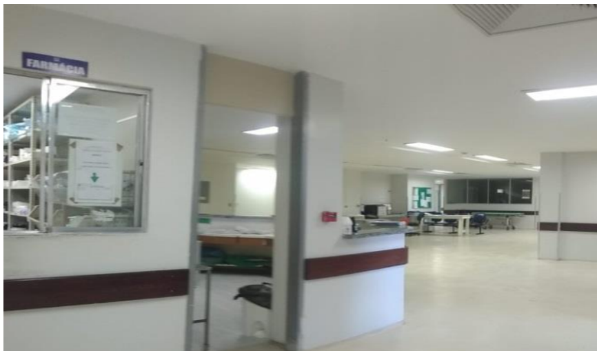
Figura 9 - Vista geral do Centro Cirúrgico – HC/UFPE
