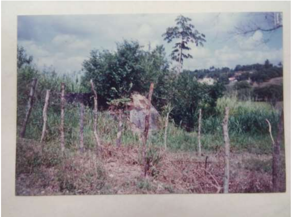
Figura 24 – Bica das Freiras deteriorada em imagem de 1992
