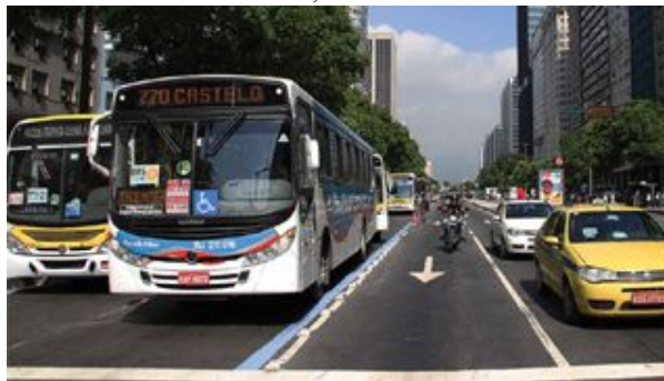
Figura 22- Corredor de BRS, com duas faixas - Rio de Janeiro
