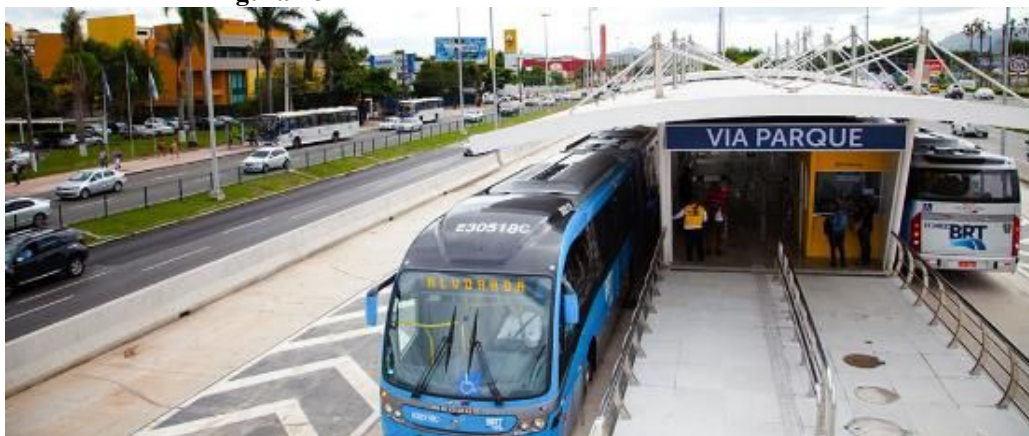
Figura 28- Corredor BRT Transcarioca - Rio de Janeiro
