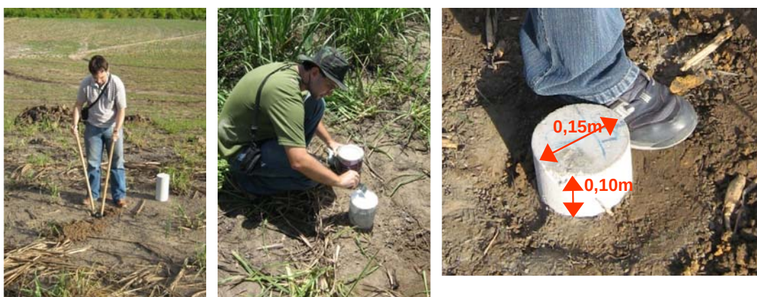
Figura 45 – Implantação dos Marcos de Referência Plani-altimétricos
