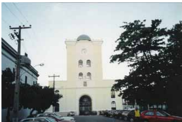
Figura 48: Torre Malackoff, após a recuperação, durante o dia. Fonte: Natália Vieira, Agosto de 2000.
