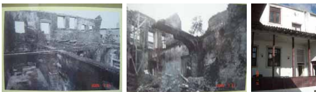
Figuras 141, 142 e 143: Pavimento Superior do Solar dos Vasconcelos, antes e depois da reconstituição. Fonte: Natália Vieira/julho de 2005.
