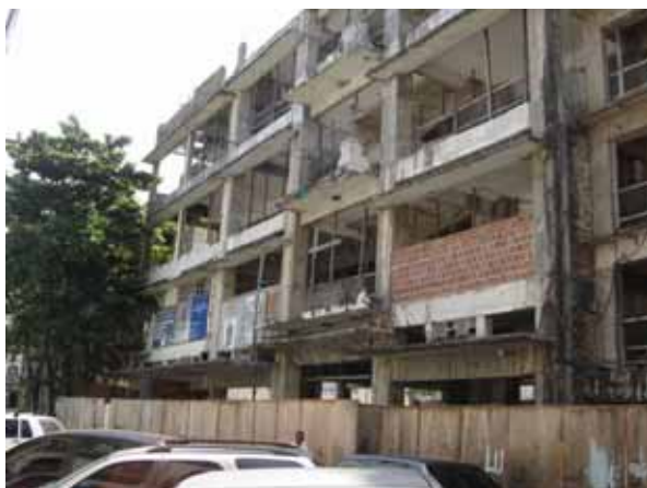
Figura 101: SOFTEX / ITBC – Construção paralisada. Fonte: Fotografia Fábio Teódulo, novembro de 2005.
