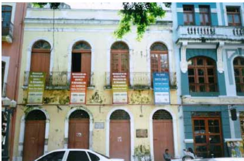
Imagem 58: Edifício, já desapropriado, da antiga Sinagoga na rua do Bom Jesus. Fonte: Natália Vieira, Agosto de 2000.
