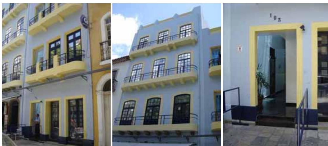
Figuras 38, 39 e 40: Transformação de edificação histórica em edifício empresarial, fachada e acesso. Fonte: Fábio Teódulo e Thaísa Marques, 2005.
