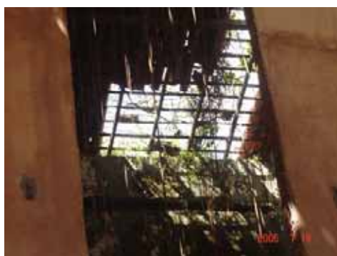
Coberta e Pavimento Superior
