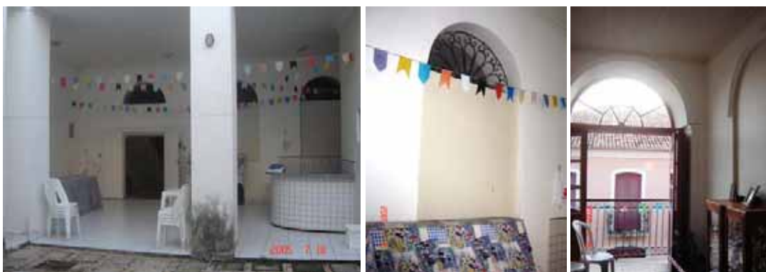
Figuras 169, 170 e 171: Exemplo 03 de adaptação para o uso residencial, nos andares superiores, e uso comercial, no térreo. Pátio interno e vista a partir da sala de um apartamento tipo (em frente, o exemplo 02 acima comentado). Observe a manutenção da marcação das aberturas através da manutenção das bandeiras, do relevo e cores diferenciadas. Fonte: Natália Vieira/Julho de 2005.
