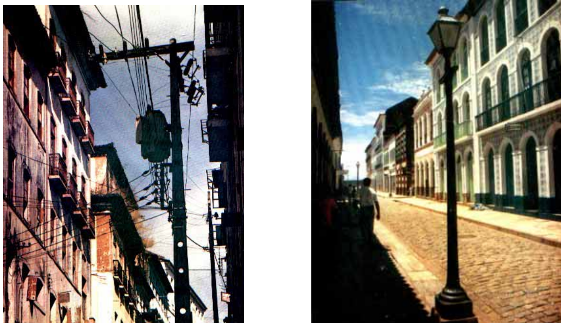
Figura 119 e 120: Bairro da Praia Grande antes e depois do embutimento da fiação elétrica com o projeto Reviver. Fonte: PEREIRA, 1992, p. 29.
