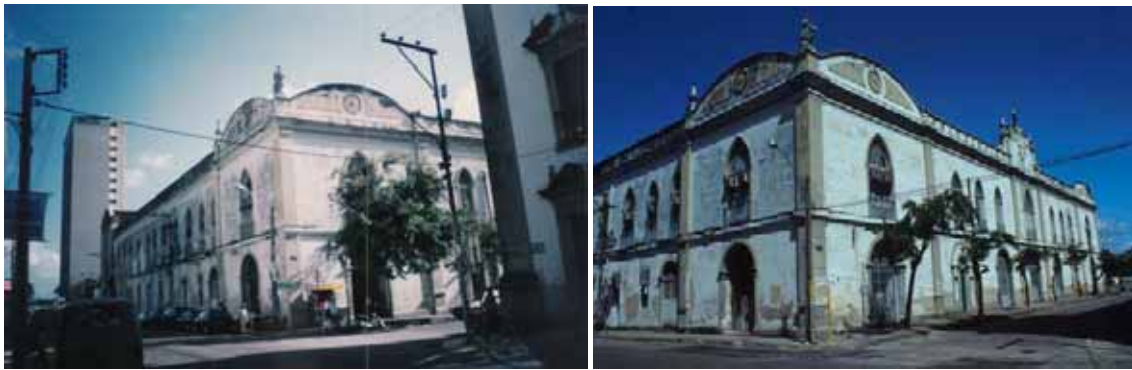
Figuras 74 e 75: Alfândega, antes da intervenção, fachadas. Fonte: Natália Vieira, outubro de 1998 e Sílvio Zancheti, 1998.
