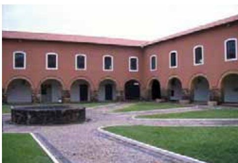
Figuras 128, 129 e 130: Convento das Mercês, durante a recuperação e após restaurado.
