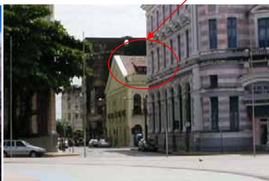
Figuras 29 e 30: Galeria Ranulpho, fachada logo após a intervenção. Volumetria alterada pela inserção do elevador (ver detalhe figura 29) e inserção de terraço superior (ver detalhe figura 30).
