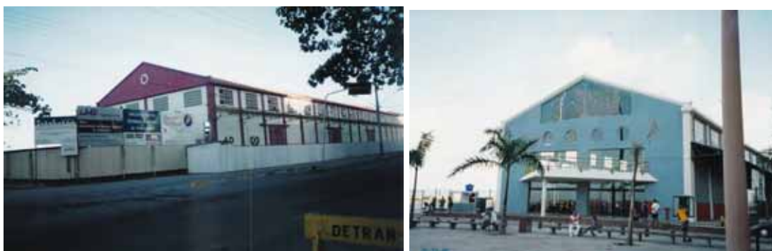
Figura 49 e 50: Armazém 12, antes e após a intervenção para torná-lo o Terminal Marítimo de passageiros. Fonte: Natália Vieira, Julho de 1999 e Agosto de 2000.
