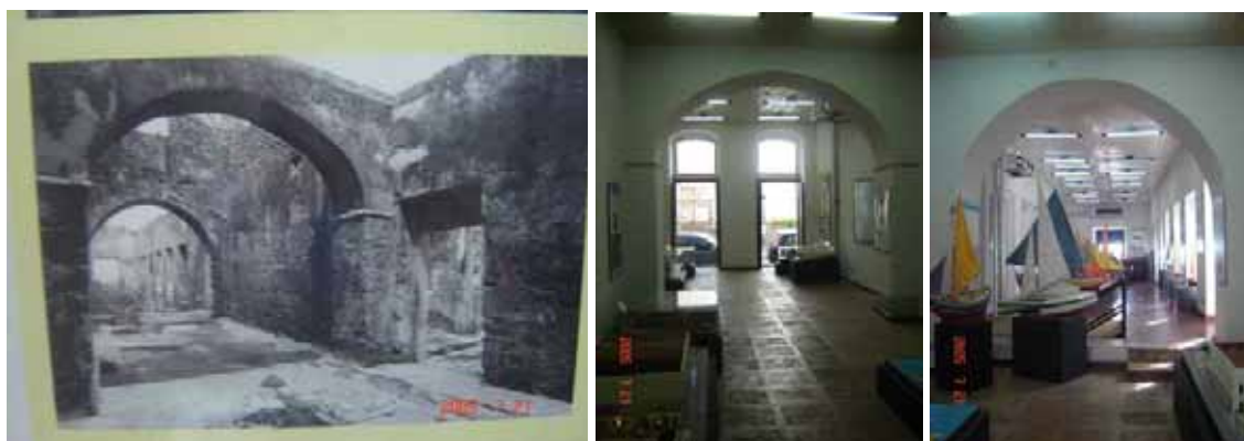
Figuras 144, 145 e 146: Pavimento térreo do Solar dos Vasconcelos, antes e depois da reconstituição. Fonte: Natália Vieira/julho de 2005.
