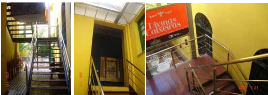
Figuras 194 e 195: “Armazém da Estrela”, área interna, escada de acesso ao andar superior localizada no pátio interno. Fonte: Natália Vieira/Julho de 2005.
