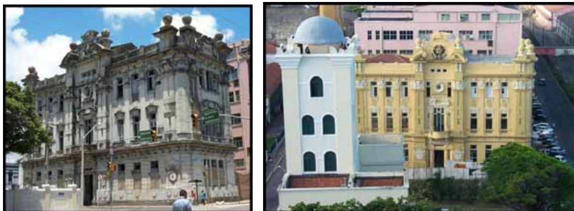
Figuras 94 e 95: Edificação no Bairro do Recife, antes e após a intervenção para a instalação da Secretaria Estadual de Ciência, Tecnologia e Meio Ambiente (SECTMA).
