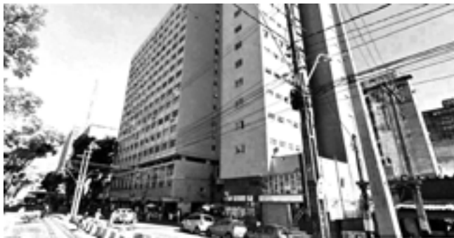
Foto 02 – Foto de uma Torre/Pódio urbana. Edifício Círculo Católico, no Centro do Recife.
