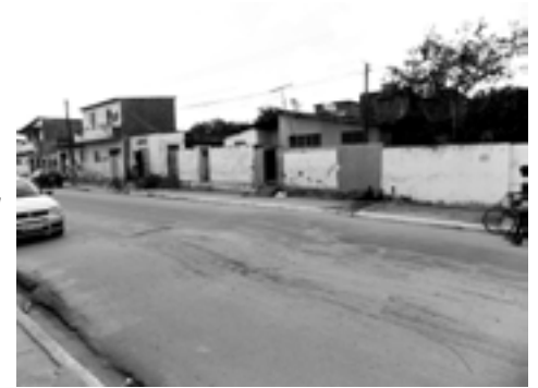
Foto 59 – Foto da Rua Central da Comunidade do Detran com habitações remanescentes de 1 pavimento.
