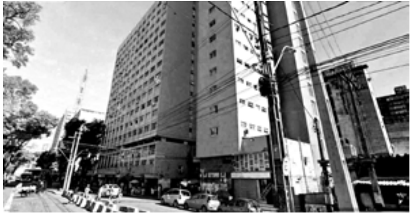
Foto 01 – Foto de uma Torre/Pódio urbana. Edifício Círculo Católico, no Centro do Recife.
