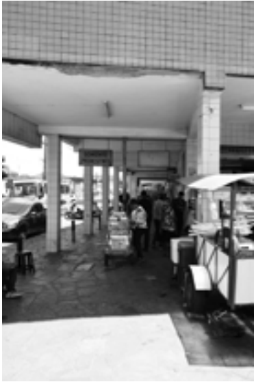
Foto 09 – Foto de Edifício-Galeria no Centro de Afogados.
