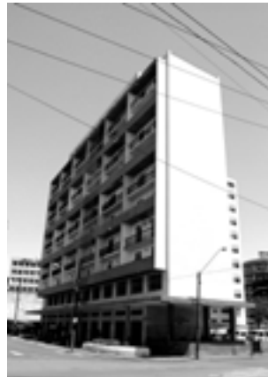
Foto 25 – Edifício Inconfidência, no Centro Recife.
