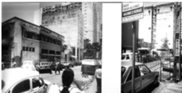
Foto 15 [montagem] – Foto da Área de Estudo (PCR) Centro do Recife onde se observa edifícios com empenas laterais cegas a espera de outro edifício para conjugação.
