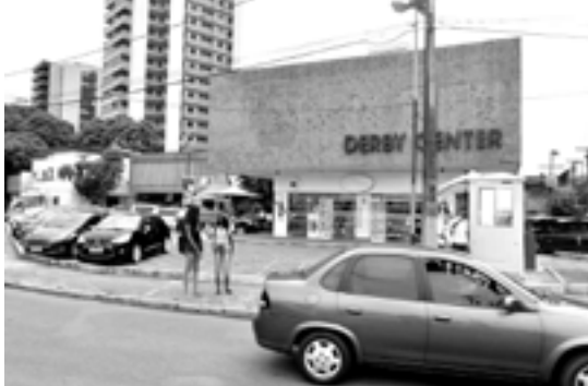
Foto 22 – Galeria Derby Center, nas Graças, Recife.
