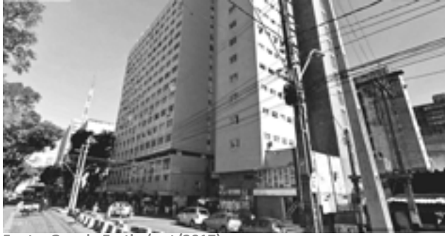
Foto 20 – Foto de uma Torre/Pódio urbana. Edifício Círculo Católico, no Centro do Recife.
