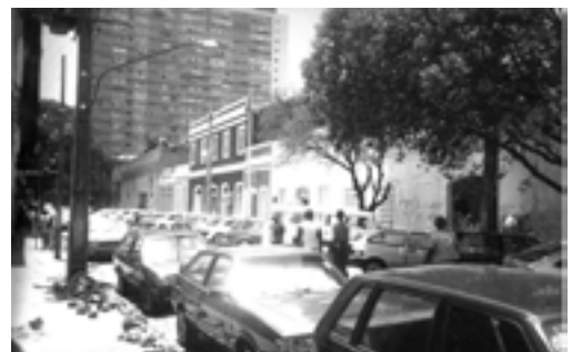
Foto 16 [montagem] – Foto da Área de Estudo (PCR), na Rua da União. As prerrogativas de preservação superaram às dos Planos de Quadras.
