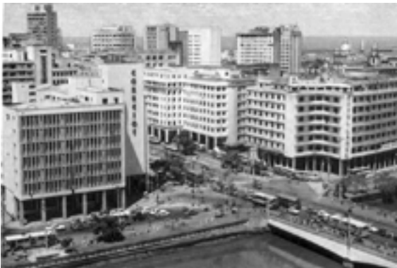
Foto 17 – Postal da Av. Guarrapes e sua tipologia de edifícios-galeria.
