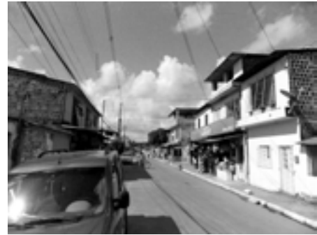
Foto 55 – Foto da Rua Central da Comunidade do Detran e sua tipologias.
