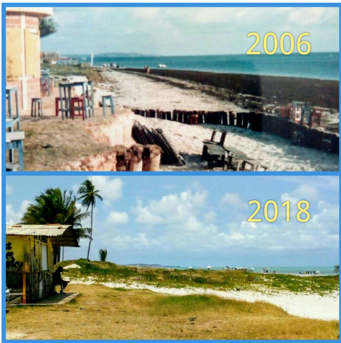
Figura 24: Evolução da praia do Jaguaribe após recuperação dos currais submersos instalados nas aberturas do recife.
