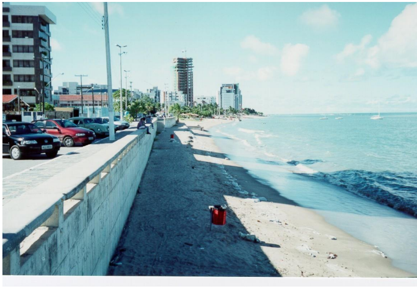
Figura 15: Muro de proteção aderente reflexivo e impermeável em Olinda.
