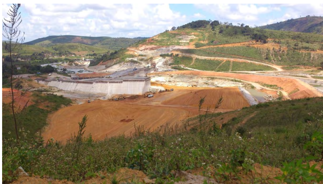
Figura 3 - Canteiro de obras da barragem de Serro Azul. Fonte: Autor. (Data: 29/08/2013) Fotografia do rio Una contemplando elementos (tipos de vegetação, rochas, etc.) da área de estudo. Fonte: Autor. (Data: 29/08/2013)
