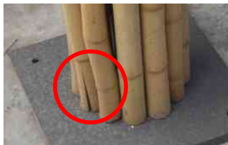
Figura 24 – Trincamentos no Bambu
