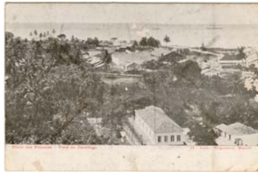
17 - Ponte dos Fonecas - Vista do Jacutinga (17) (2 ex.) foto: anônima JLMM: s.d./s. post./s.env. JBO: s.d./s.post./s.env.
