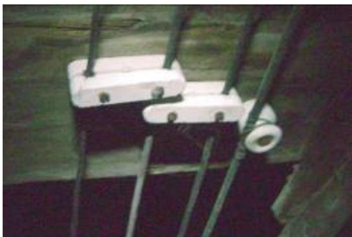
Figura 8: Condutores de cobre isolado com borracha vulcanizada, revestido com cambraia, fixados em suportes isoladores de porcelana, Basílica da Penha. Fonte: CECI, 2007
