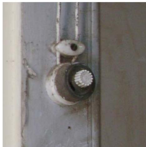
Figura 9: Isolador e interruptor de porcelana e baquelite, Basílica da Penha. Fonte: CECI, 2007
