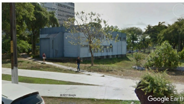
Figura 17: Laboratório de Nanoestruturas (CTG).
