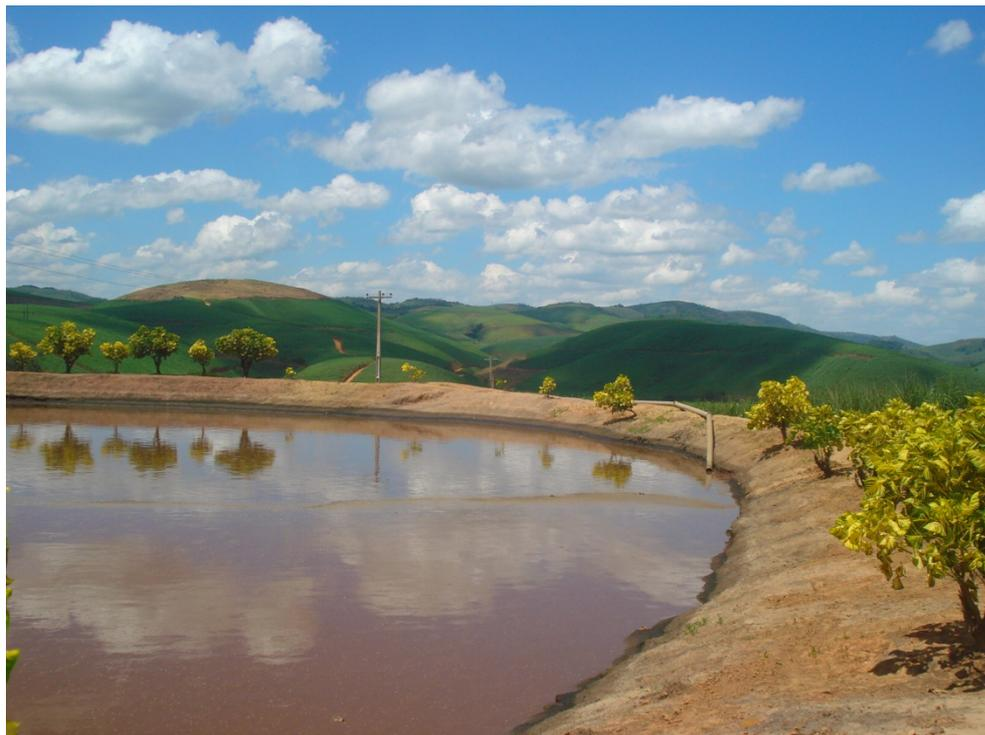
Figura 14: Lagoa sem impermeabilização destinada ao armazenamento de vinhoto. Fonte: a autora, 2010.
