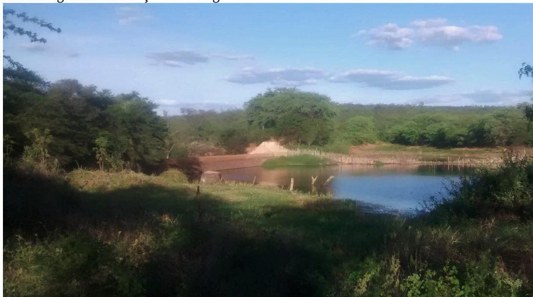
Figura 68 – Atuação de barragem de concreto como barrier no Riacho Grande
