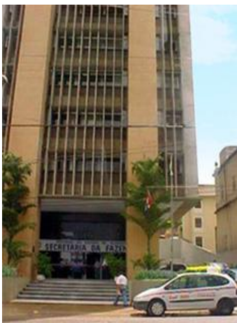
Figura 16 – Atual Sede da Sefaz/AL
