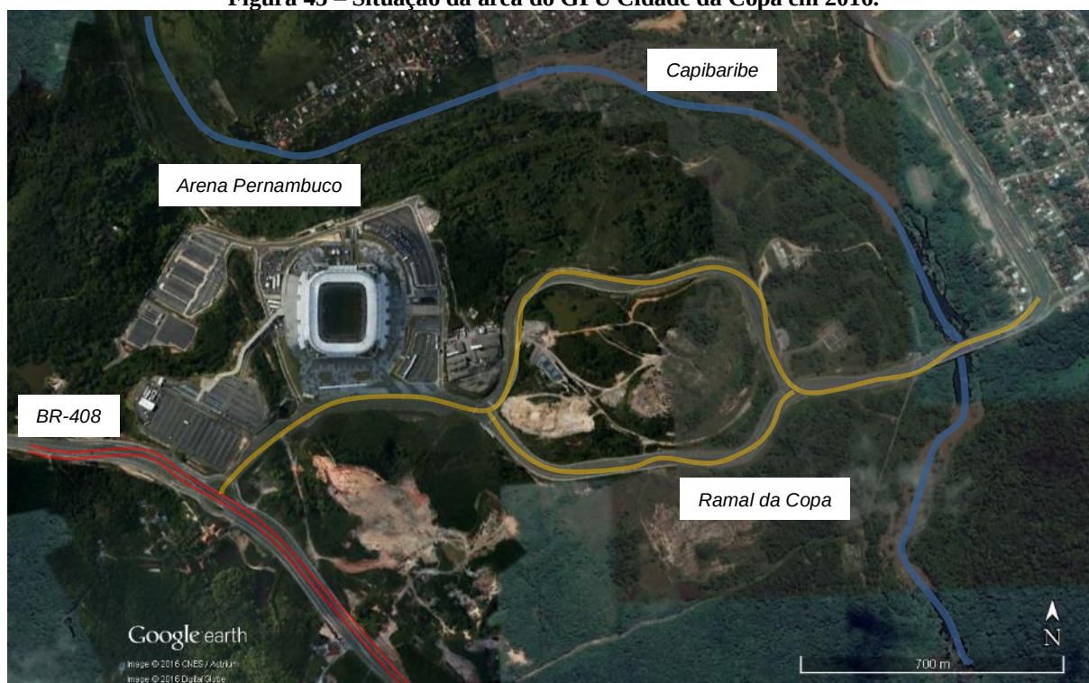
Figura 45 – Situação da área do GPU Cidade da Copa em 2016.
