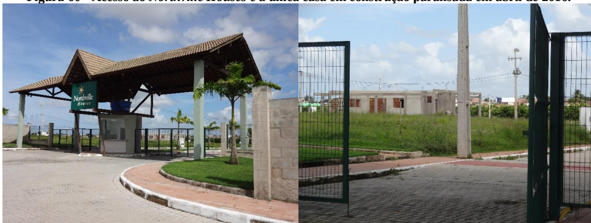
Figura 60 - Acesso ao Northville Houses e a única casa em construção paralisada em abril de 2016.
