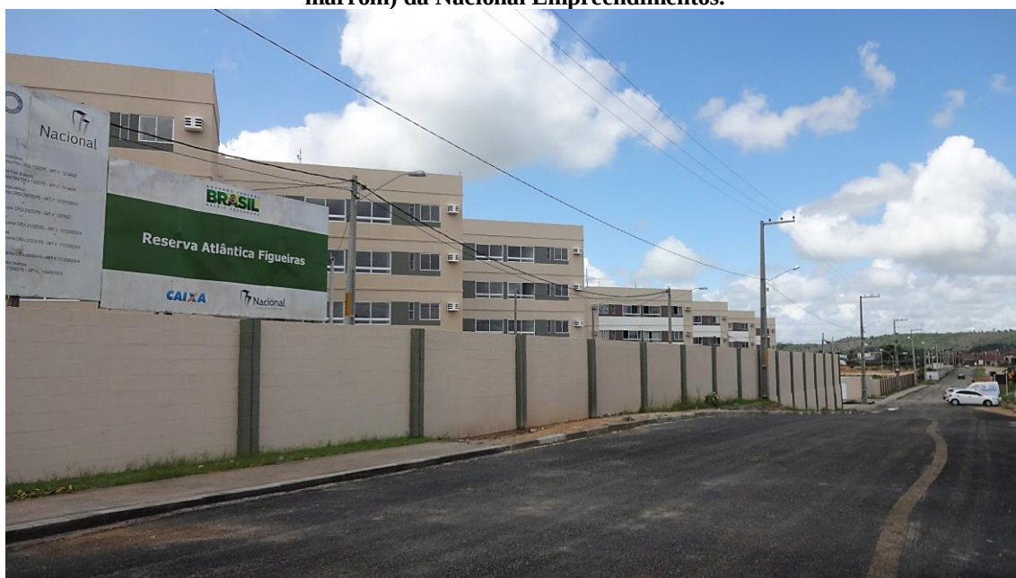
Figura 84 – Condomínio Reserva Atlântica Figueiras (com detalhes em verde) e Jatobás (com detalhes em marrom) da Nacional Empreendimentos.
