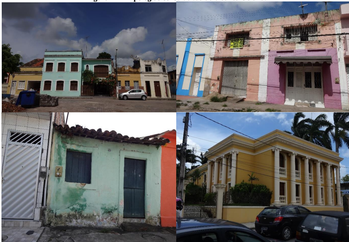
Figura 24 – Tipologias construtivas do distrito Goiana.
