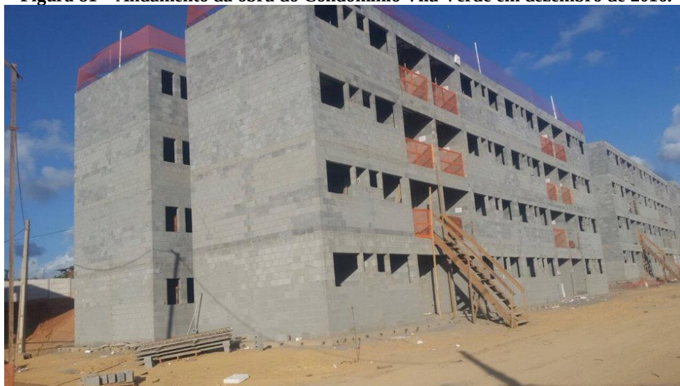
Figura 81 – Andamento da obra do Condomínio Vila Verde em dezembro de 2016.
