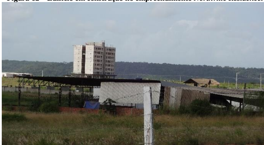
Figura 62 – Edifício em construção no empreendimento Northville Residence .
