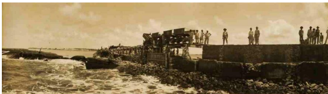
Figura 13: Fotografia da construção do Dique do Nogueira.
