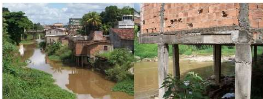
Construções na margem do rio Jaboatão
