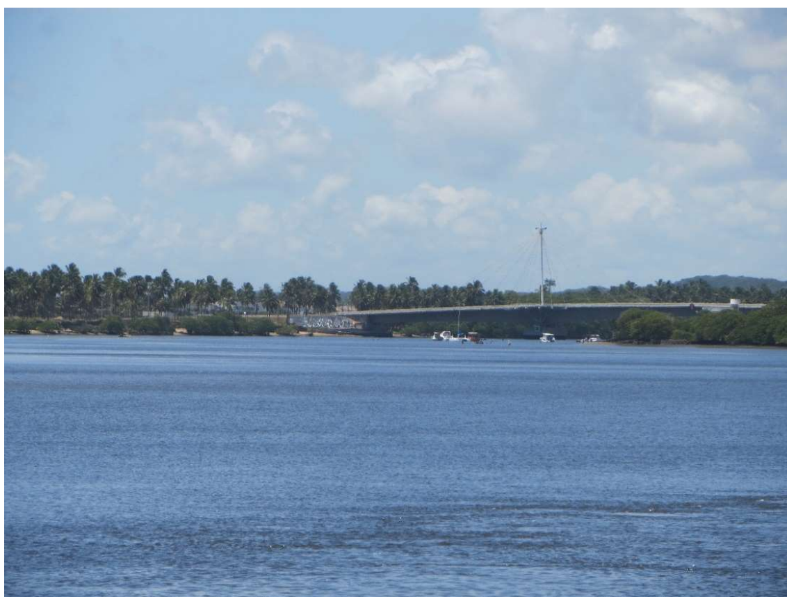
Figura 31 – Ponte do Paiva
