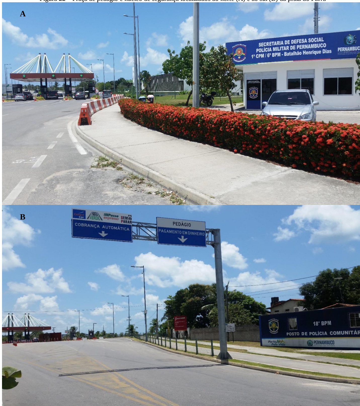
Figura 22 – Praça de pedágio e núcleo de segurança localizados ao norte (A) e ao sul (B) da praia do Paiva
