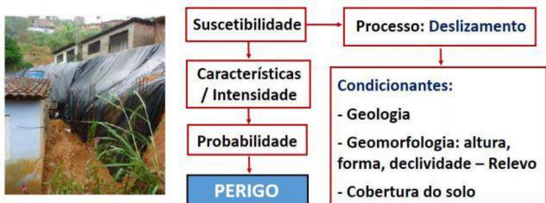
Figura 4.3 – Moradias próximas a cortes inadequados com presença de lonas plásticas evidenciando movimentação de massa no município de Ipojuca-PE, em 2015.
