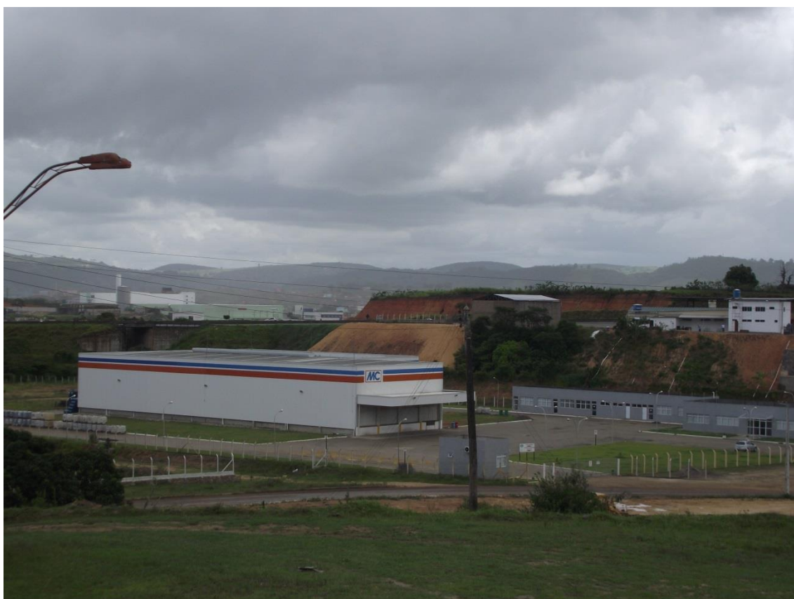
Imagem 8 - Instalação da Empresa MC Bauchemie, Engenho Bento Velho, Luann Ribeiro 2014.
