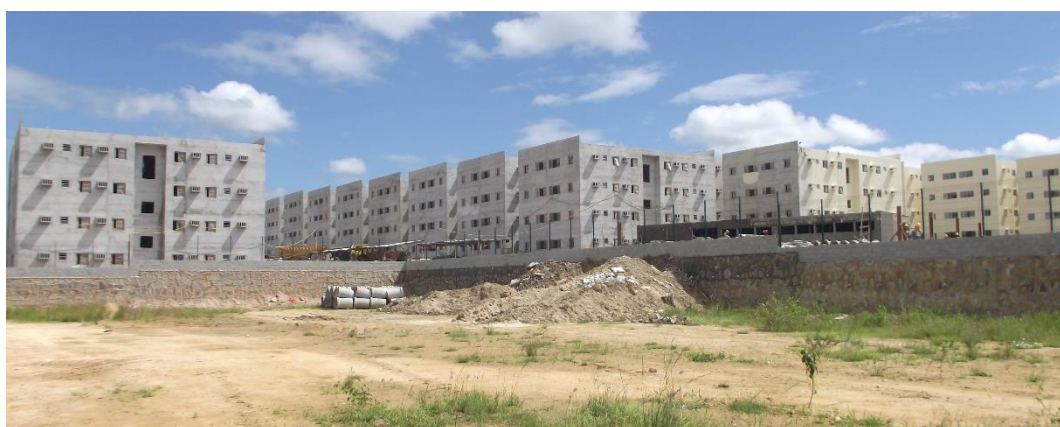
Imagem 7 – Obra em andamento do Residencial Águas Claras (Minha Casa, Minha Vida), Vitória de
