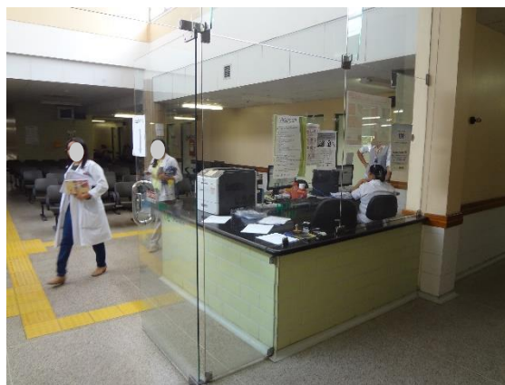
Figura 100 – Portas em vidro sem sinalização
