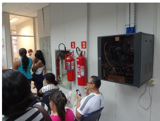
Figura 150 – Risco com equipamentos
