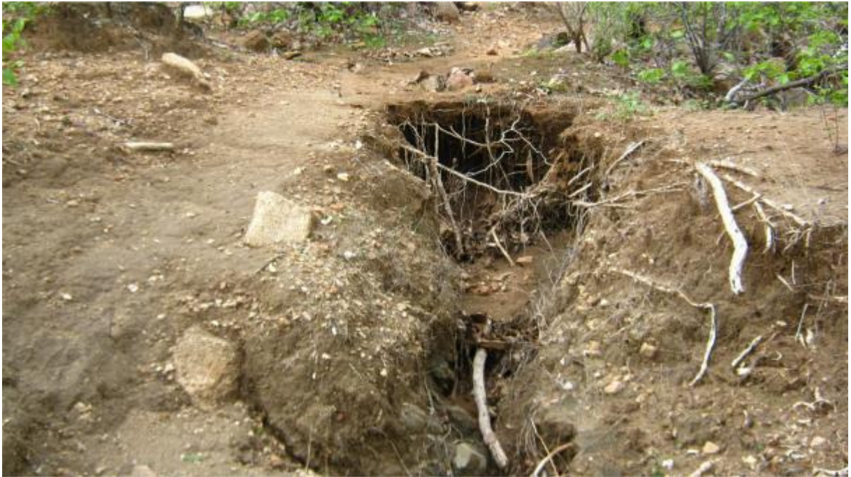
Figura 42: Duto de erosão hipodérmica ( piping ) (Fotografia: Raul Carneiro).
