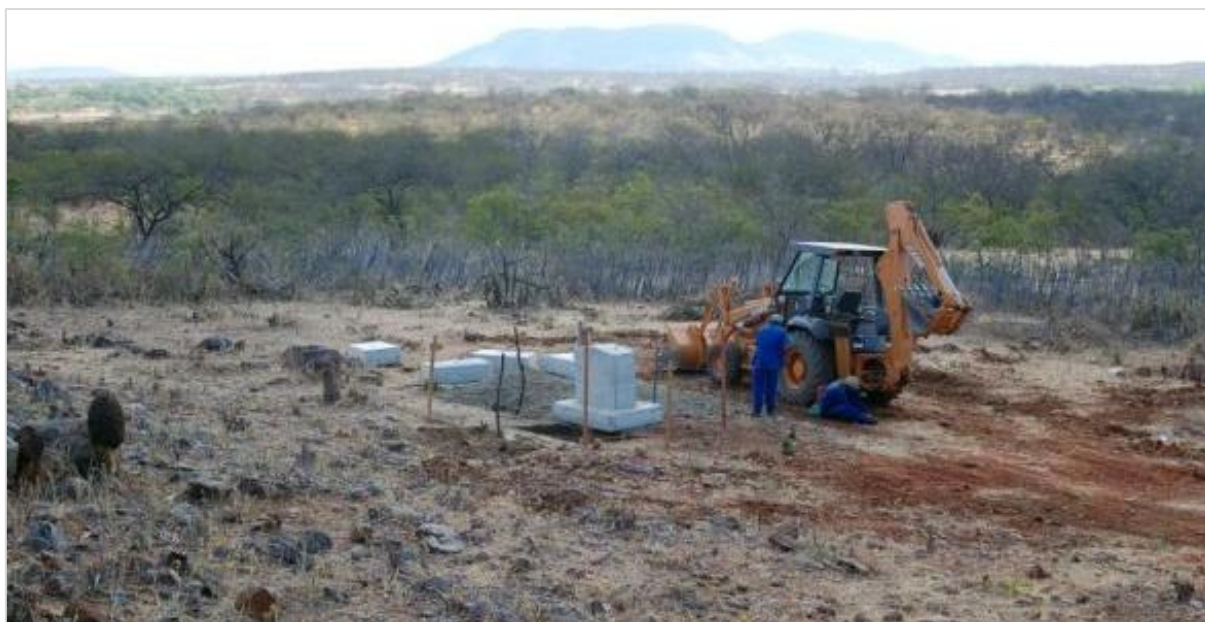
Figura 1: Intervenções e equipamentos pesados na área do sítio VZBII. Ao fundo, o Serrote Quinamuiú.
