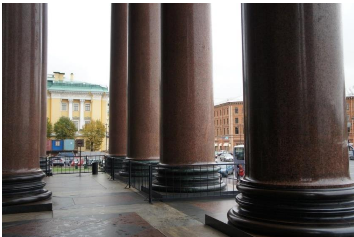
Figura 36 - Detalhe das colunas externas da Igreja de São Isaac
