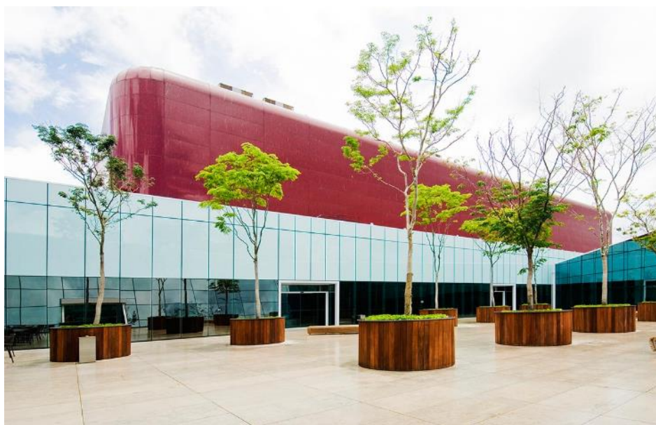
Figura 71 – Piso interno do Shopping Pátio Batel (Curitiba/PR)
