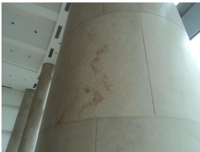
Figura 84 – Detalhe das placas de limestone que revestem os pilares da Torre Z
