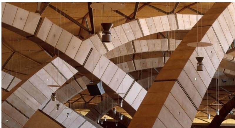
Figura 62 – Detalhe da estrutura do Santuário de São Pio
