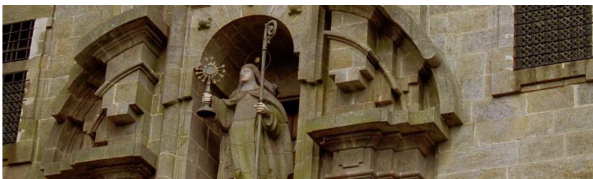
Figura 34 - Detalhe da fachada do Convento de Las Claras (Santiago de Compostela, Espanha)
