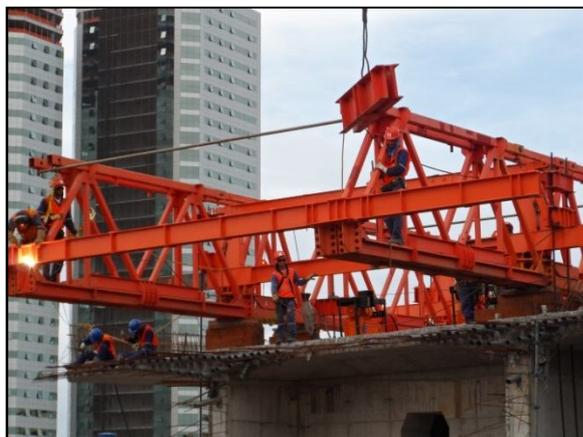
Figura 18 – Içamento e montagem de treliça.
