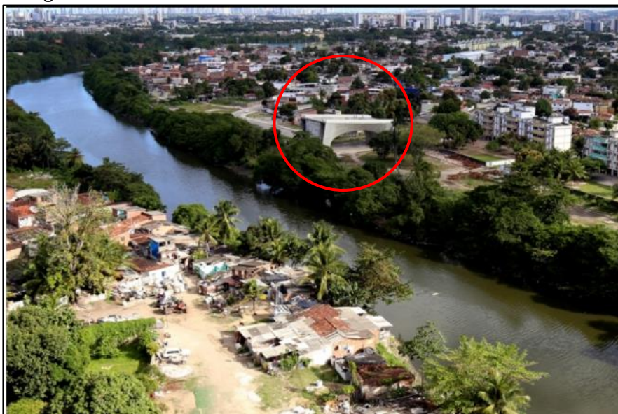
Figura 40: Ponte inacabada no bairro do Monteiro.
