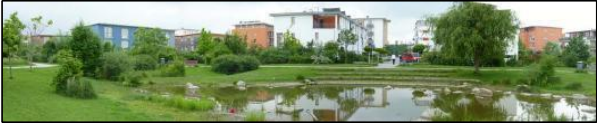
Figura 11: Lago multifuncional que retém e detém as águas pluviais que recebe de uma rede de biovaletas.
