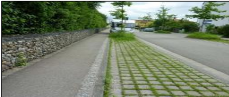
Figura 09: Estacionamento e pavimentação drenantes.
