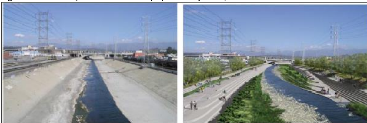
Figura 60: Vista da seção canalizada do rio e posposta da seção recuperada no centro da cidade.
