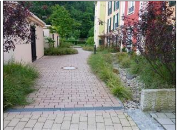
Figura 14: Canteiro pluvial e Figura 15: Entrada às residências, com a drenagem natural visível.
