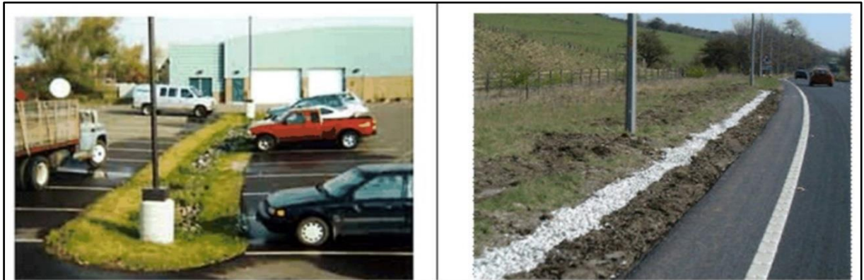
Figura 17: Trincheiras de Infiltração
