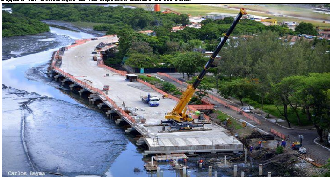
Figura 41: Construção da via expressa dentro do rio Pina.
