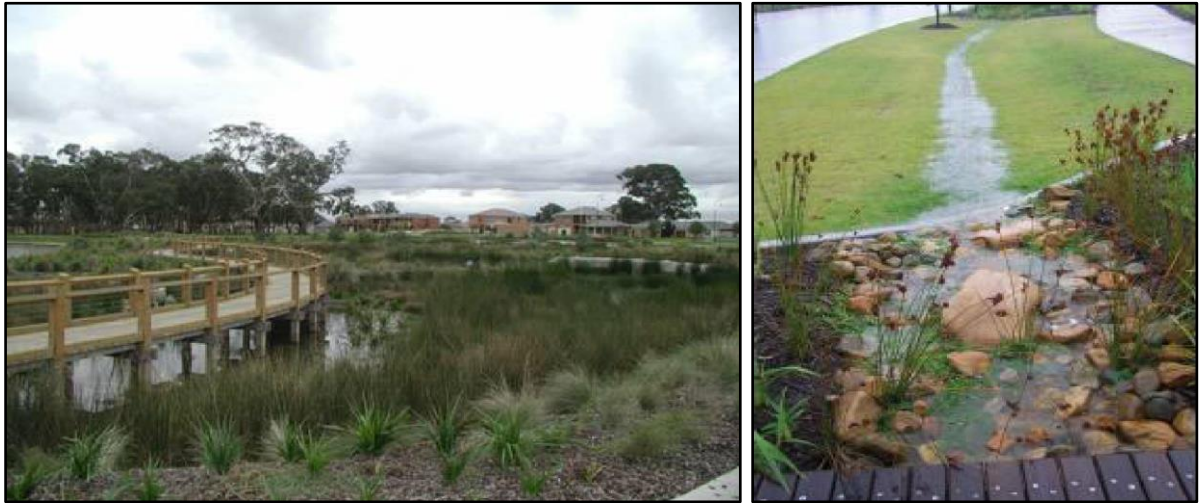
Figura 19: Zonas úmidas de tratamento de águas pluviais na Austrália
