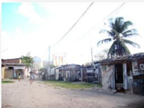
FIGURA 3: SITUAÇÃO ATUAL DA CP- VISTA DO MOINHO AO
