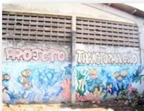
Figura 37: Pichações nos muros da CP. Fonte: Autoria própria
