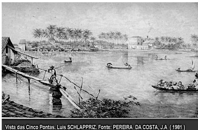
Figura 10: Vista das Cinco Pontas em Recife-PE.. Fonte: Pereira da Costa, J.A (1981).
