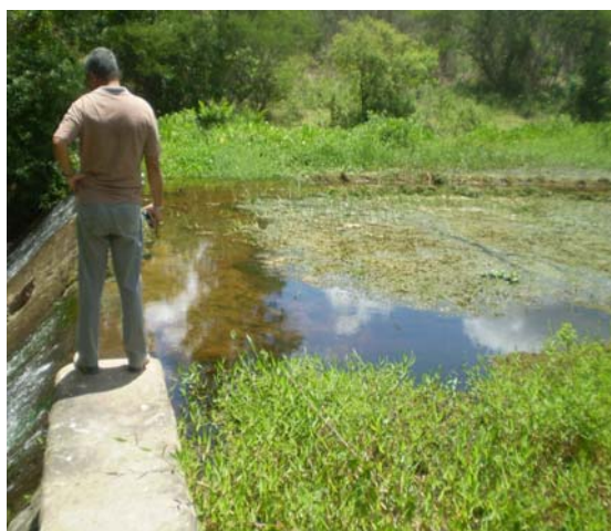
Figura 25: Fotos da obra de captação provisória para aumento da oferta de água em Garanhuns Fonte: COMPESA, 2009.
