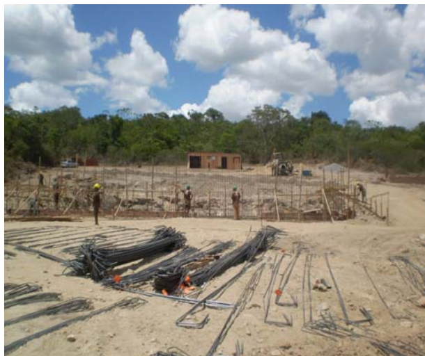
Figura 26: Fotos da obra do sistema produtor instalação da adutora e unidades de produção Fonte: COMPESA, 2009.
