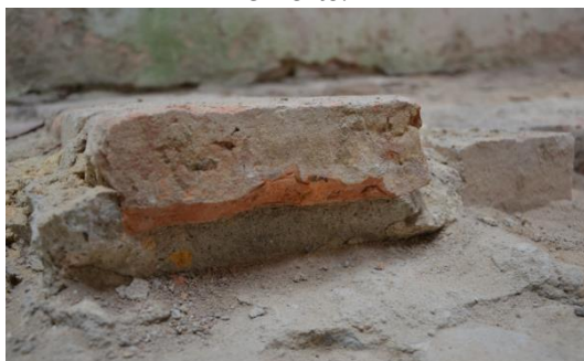
Figura 120: Detalhe de tijolos que compõe alicerce; presença de argamassa composta por cimento.
