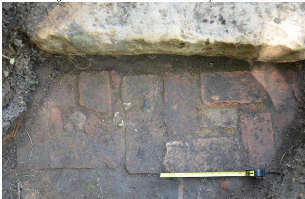
Figura 106: UE 64 cantaria e UE 66 alicerce de tijolos cerâmicos.
