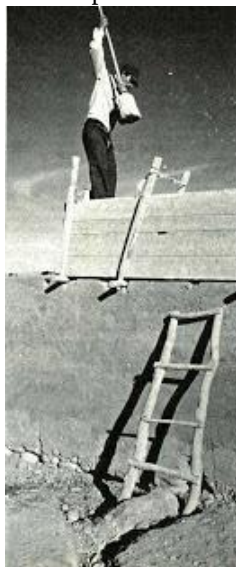
Figura 34: Exemplo de construções em taipa de pilão.
