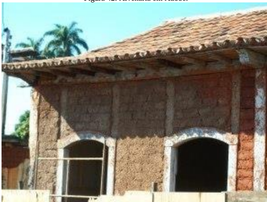
Figura 42: Alvenaria em Adobe.
