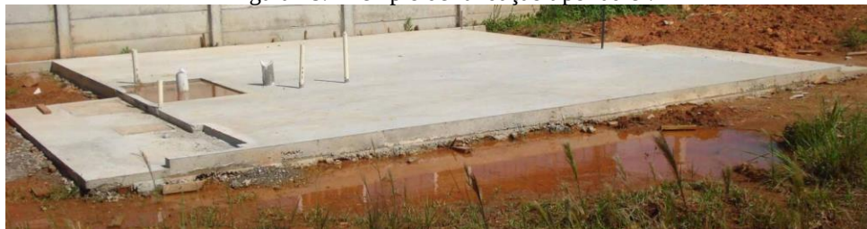
Figura 28: Exemplo de fundação tipo radier.
