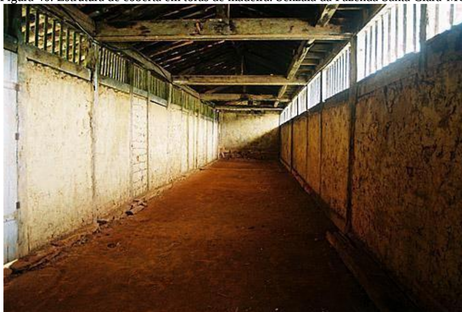
Figura 46: Estrutura de coberta em toras de madeira. Senzala da Fazenda Santa Clara-MG.
