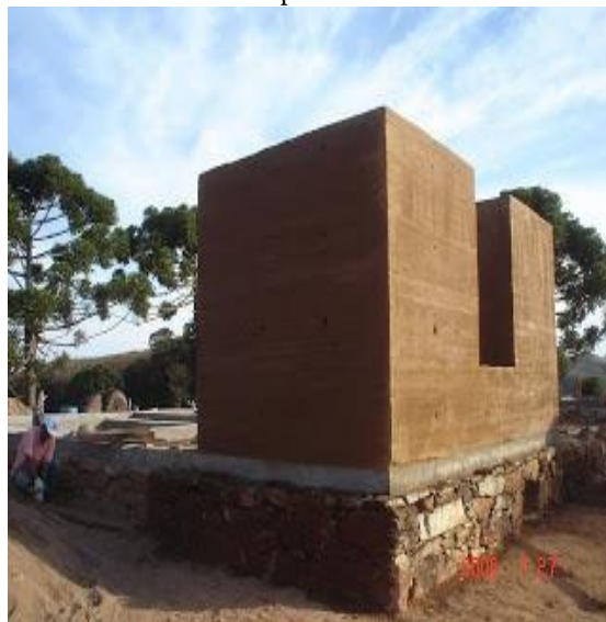
Figura 35: Exemplo de construções em taipa de pilão.
