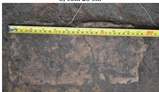
Figura 107: Tijolo cerâmico maciço da estrutura 3, com 25 cm
