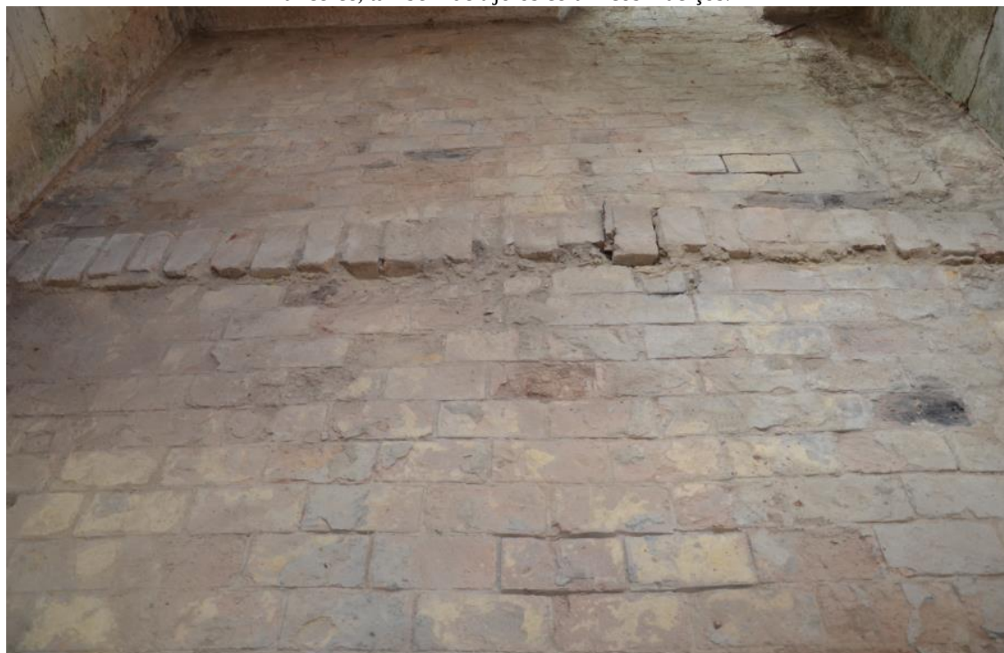
Figura 118: Cômodo sem camada de cimento, revelando piso de tijolos cerâmicos e ao meio, tipo de alicerce, também de tijolos cerâmicos maciços.
