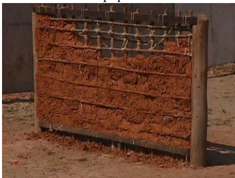
Figura 30: Exemplo de construção de pau-a-pique.
