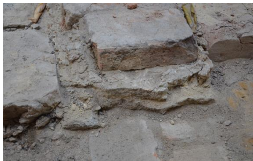
Figura 121: Detalhe de tijolos que compõe alicerce; presença de argamassa composta por cimento.
