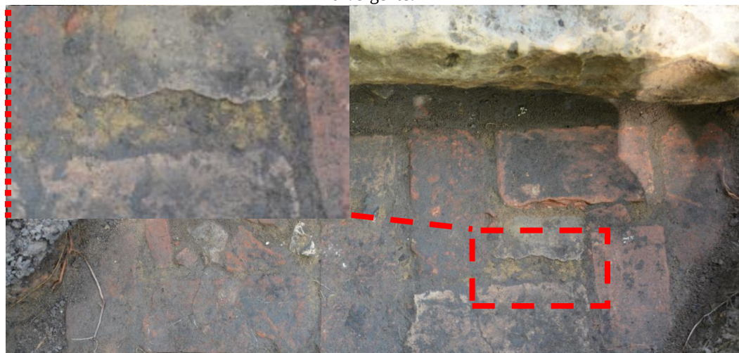
Figura 122: Estrutura 4, que utiliza areia e cal como argamassa. A disposição dos tijolos também é divergente.
