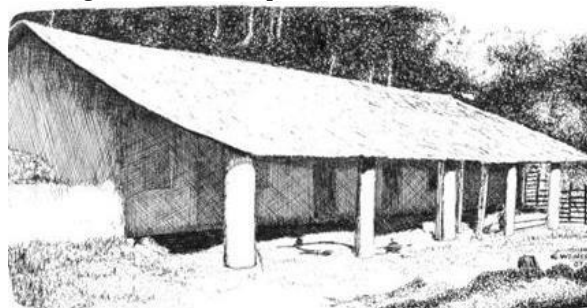
Figura 18: Senzala pavilhão com avarandado
