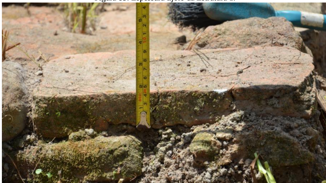
Figura 85: Espessura tijolo da Estrutura 1.
