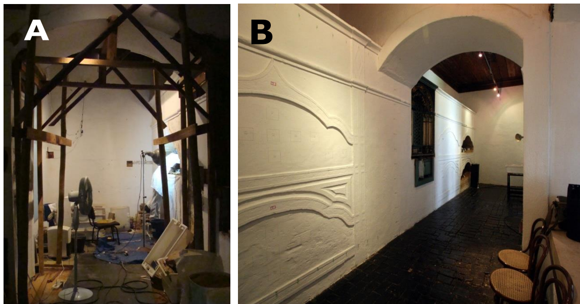
Figura 11: Vista geral da cripta mortuária do claustro: A – estrutura de madeira montada para garantir a sustentação do arco; B – vista geral da cripta, com o altar fúnebre e dois carneiros escavados.
