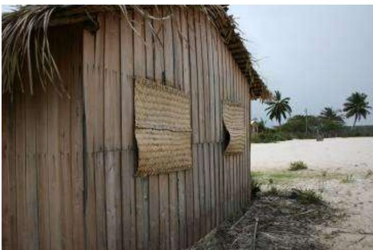
**Figura 163 Detalhe de janelas em palha, Maranhão**
