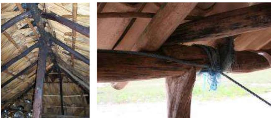
**Figura 147 Exemplos de uso de forquilha na estrutura, Maranhão e Ceará.**
