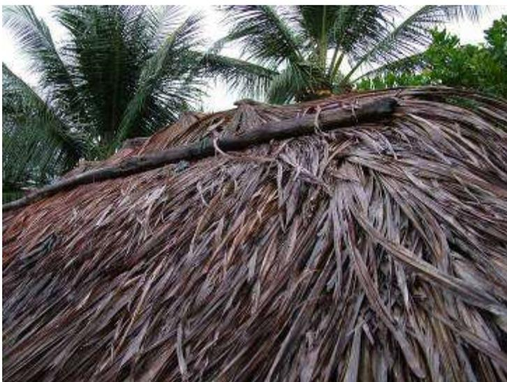
**Figura 154** Detalhe de cobertura em palha de babaçu, Maranhão.
