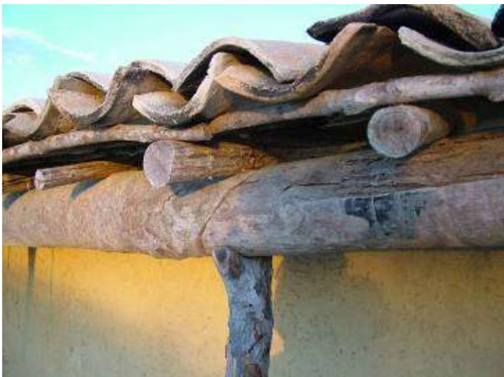
**Figura 157 Detalhe de estrutura de cobertura em telha cerâmica, Ceará.**
