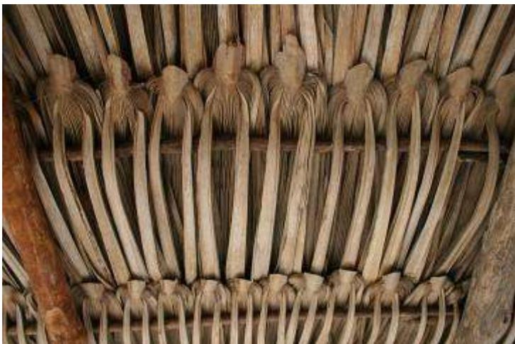
**Figura 155** Detalha execução de amarração de cobertura de palha de carnaúba, Ceará.
