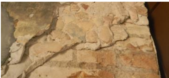
ILUSTRAÇÃO 56: DETALHE DO REBOCO DA CELA, 2011.
