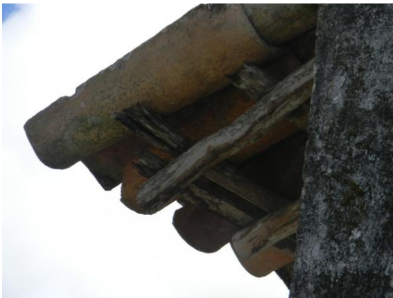
ILUSTRAÇÃO 48: ESTRUTURA DA COBERTA EM CAIBROS ROLIÇOS, 2011.
