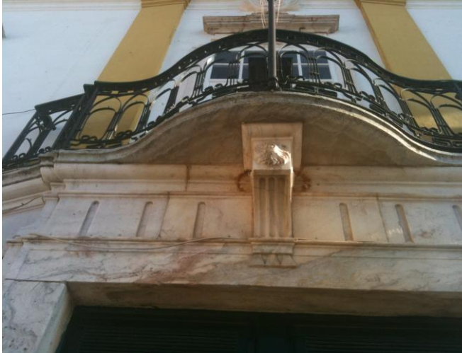
ILUSTRAÇÃO 25: DETALHE DO PÓRTICO DE ENTRADA PRINCIPAL EM CANTARIA, 2011.
