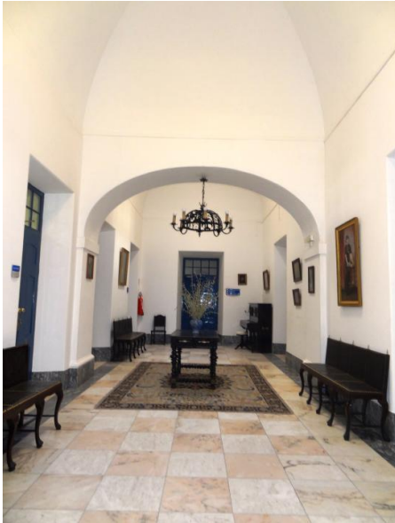
ILUSTRAÇÃO 21: CIRCULAÇÃO DE ACESSO ÀS SALAS DO PAVIMENTO SUPERIOR, 2012. Abertura no centro do hall em arco romano que divide o teto com o pé-direito de altura superior em abóbada de aresta.
