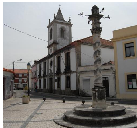
ILUSTRAÇÃO 8: CASA DO CONCELHO DE ESGUEIRA COM TORRE SINEIRA E PELOURINHO. 2010.
