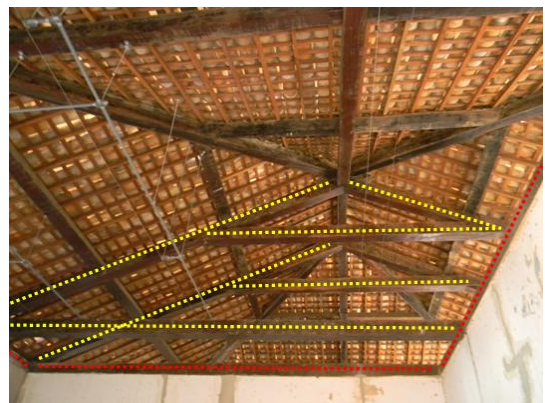
ILUSTRAÇÃO 57: ESTRUTURA DA COBERTA, 2011.
