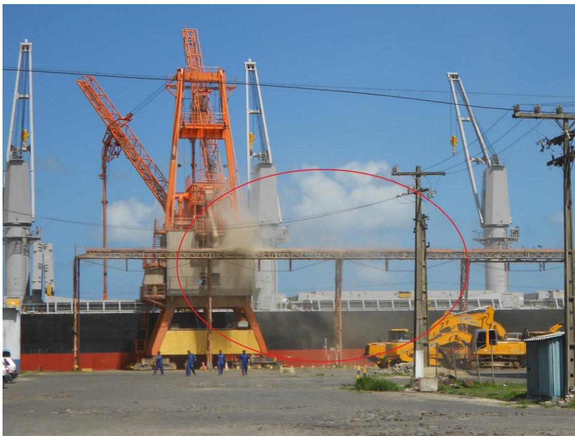
Figura 9 – Resíduos Dispersos em Operação de Descarga no Porto do Recife
