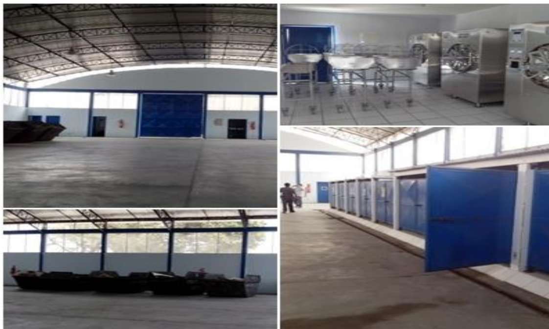
Figura 12 – Central de Resíduos da área Pública do Porto do Recife
