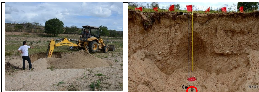
Figura 3. 5 – Construção da trincheira na área 1, calha principal do Alto Rio Capibaribe.
