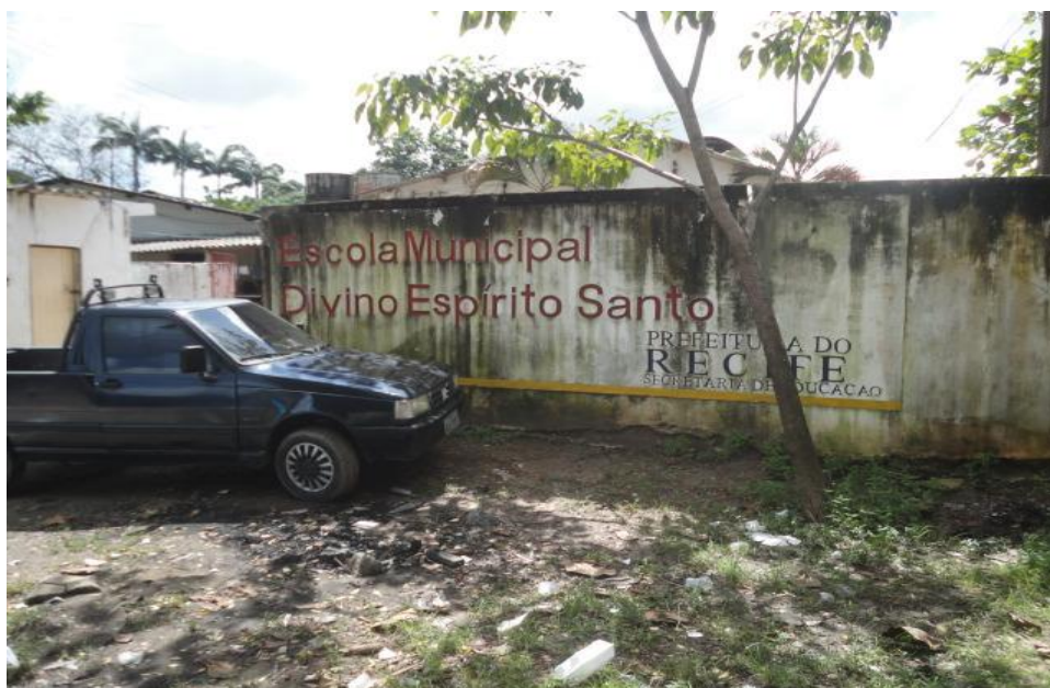
FIGURA 3: Vista Frontal da Entrada da EMDES– Recife, 2011.
