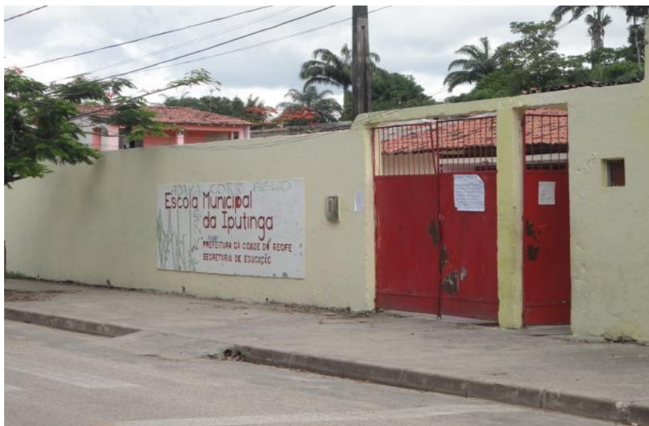
FIGURA 6 – Fachada Principal da EMDIP
