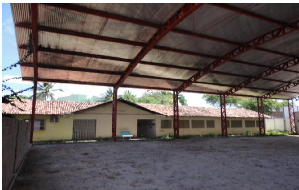
FIGURA 10 – Quadra Coberta (inacabada) da EMDIP
