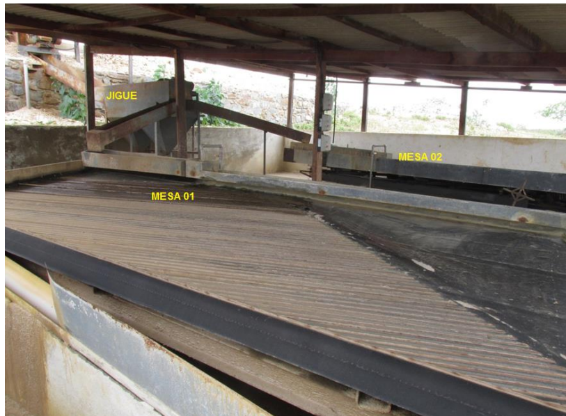
Figura 18 – Jigue e Mesas para concentração gravimétrica da Planta Piloto na Fazenda Primavera.
