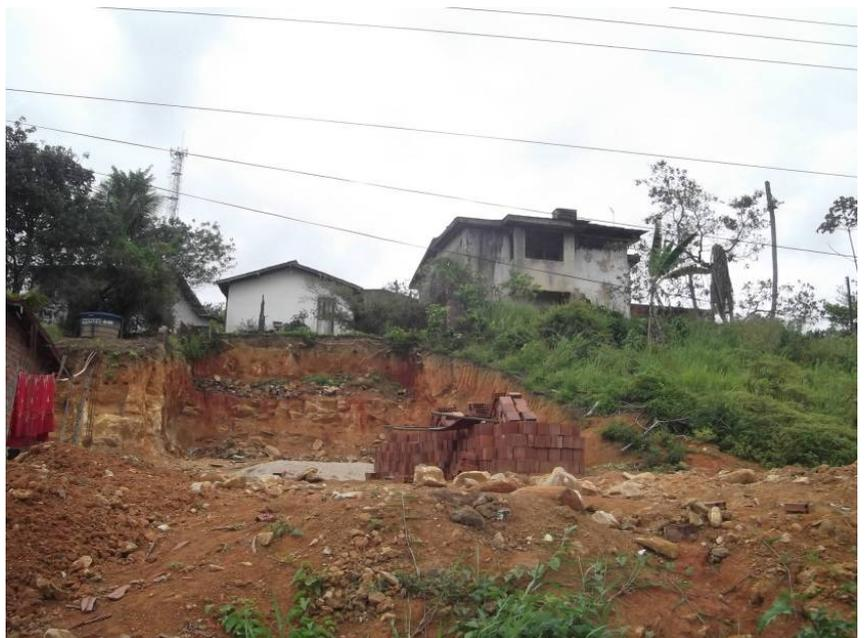
**Foto 39: Corte irregular de barreiras para a construção de casas, comprometendo a estabilidade do terreno e a segurança de famílias. Fonte: a autora, em outubro de 2014.**
