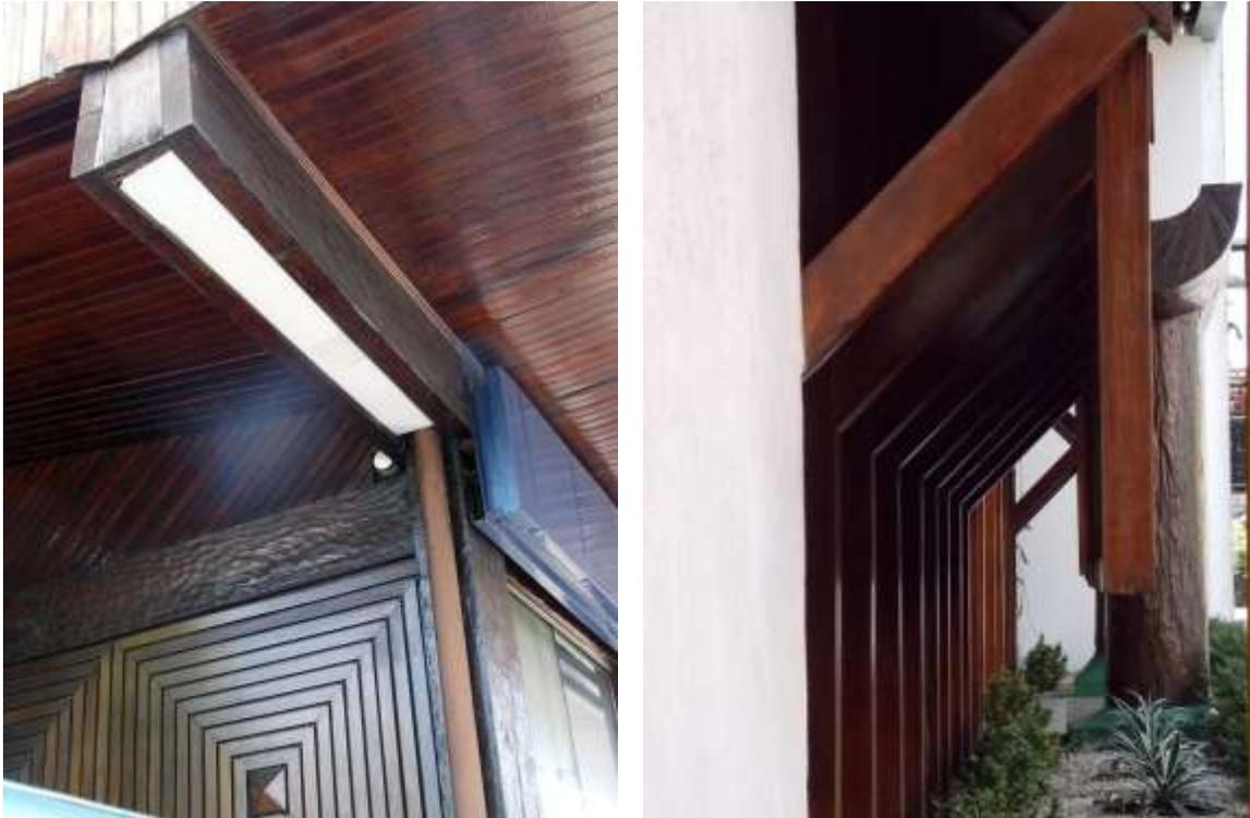
Fig. 257: Vista da esquina da Credilar Teatro demonstrando a estrutura de madeira com a viga sacando que tem a dupla função de coletar as águas da calha superior e embute uma luminária na parte inferior. Foto: CANTALICE II.
