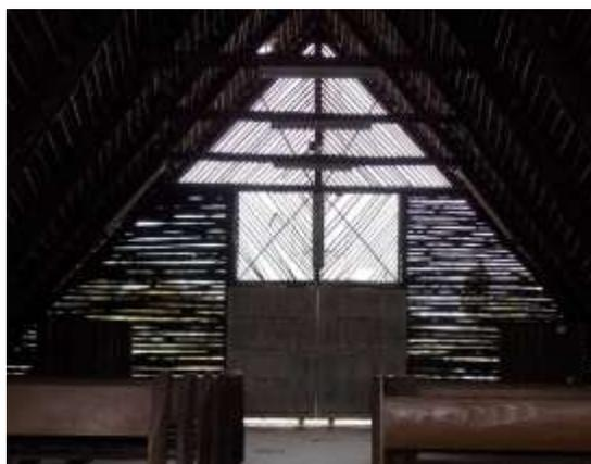
Fig. 237: Sistema de muxarabi vazado em madeira roliça do Centro Ecumênico do cavaco. Foto: CANTALICE II.
