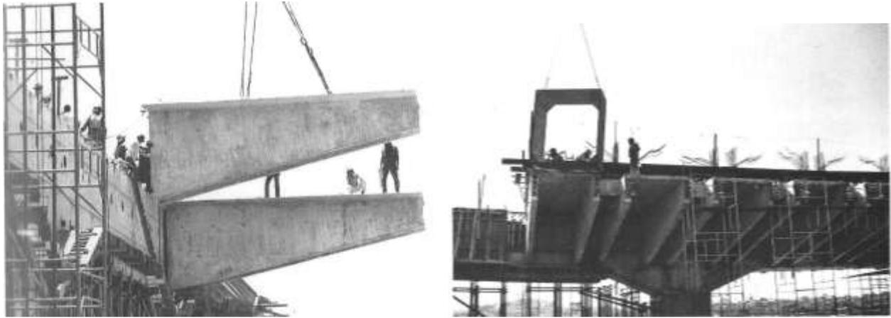
Fig. 410: Vista da montagem de uma viga misulada. Fonte: LATORRACA, 1999, p. 61.
