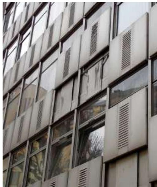
Fig. 448: Vista do complexo sistema de esquadrias com vedação de iluminação, abertura do vidro por corredeira, abertura por dobradiça e beiral da chapa posterior, numa fachada concebida por Jean Prouvé para o prédio da Square Mozard de Mirabaud e Gondolff, 1954. Foto: CANTALICE II.
