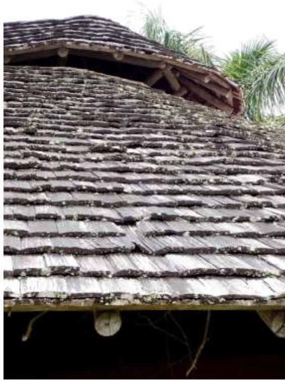
Fig. 255: Detalhe da armação que, apesar de se basear na arquitetura primitiva, o trato das peças roliças e dos encaixes denota releituras técnicas que fazem sua execução mais prática e confortável na atualidade. Foto: CANTALICE II.
