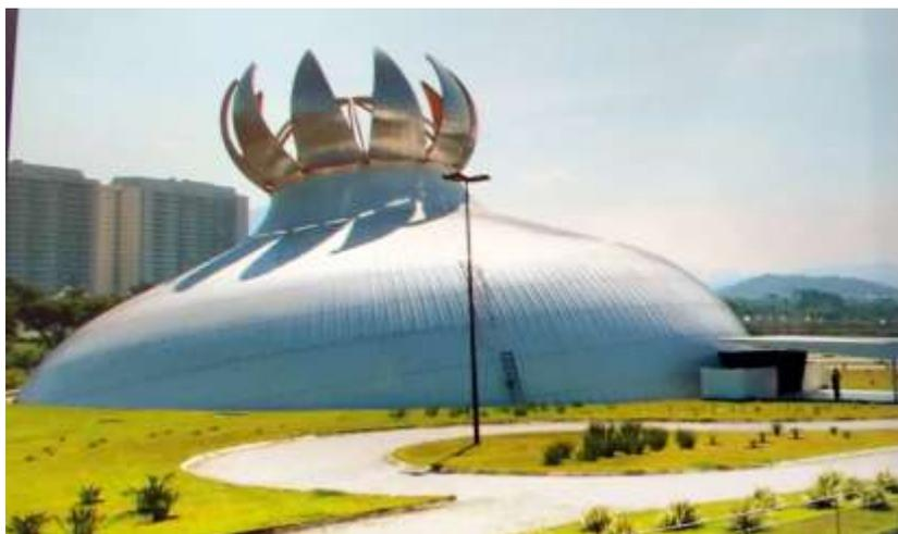
Fig. 449: Cúpula com abertura mecanizada do Hospital do Rio de Janeiro, Lelé. Fonte: Expo Lelé.
