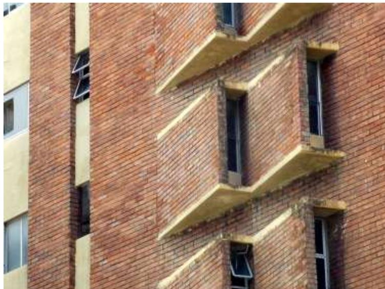
Fig. 160: Orelhas com bordas de concreto e vedação de tijolo do Edifício Mirage. Foto: CANTALICE II.
