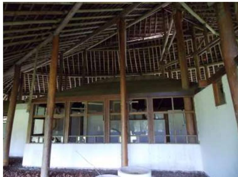
Fig. 357: Vista do setor de laboratórios com um pilar perfurando o forro do bloco. Foto: CANTALICE II.
