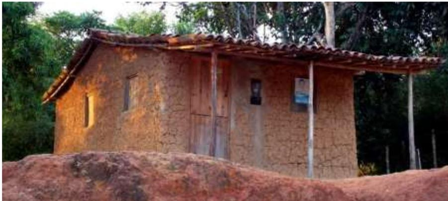
Fig. 128: Exemplo de uma casa vernácula no município de Paudalho-PE concebida com a técnica da taipa de mão, as fissuras aparecem por causa da evaporação da água. Foto: CANTALICE II.
