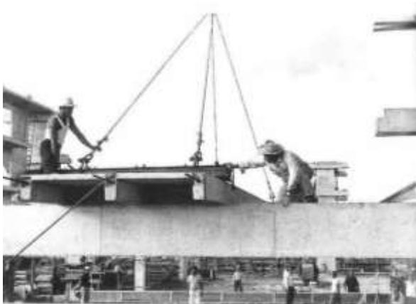
Fig. 394: Vista do processo de montagem da laje nervurada sobre a viga de concreto protendido. Apartamentos para professores da UnB, Lelé, 1962. Fonte: LATORRACA, 1999, p. 36.
