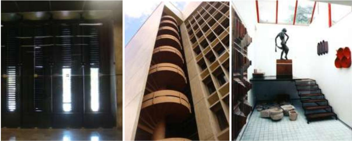
Fig. 182: Vista do pano de vidro metálico com suas duas partes, a estrutura de metal do vidro e a esquadria móvel das seteiras do Ministério da Fazenda. Foto: CANTALICE II.
