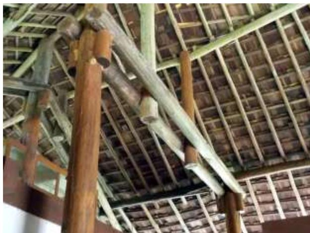
Fig. 331: Vista de um pilar à frente que possui encaixe para viga e de um posterior com encaixe para empena reforçado com chapa. Foto: CANTALICE II.
