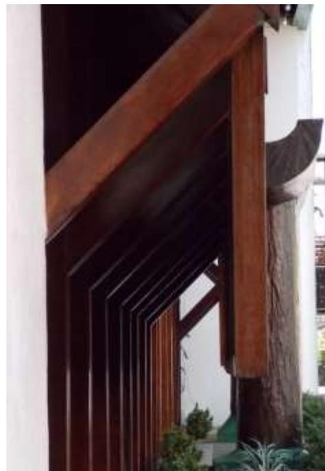
Fig. 306: Detalhe da moldura tripla do BASA com encaixe macho-fêmea. Foto: CANTALICE II.
