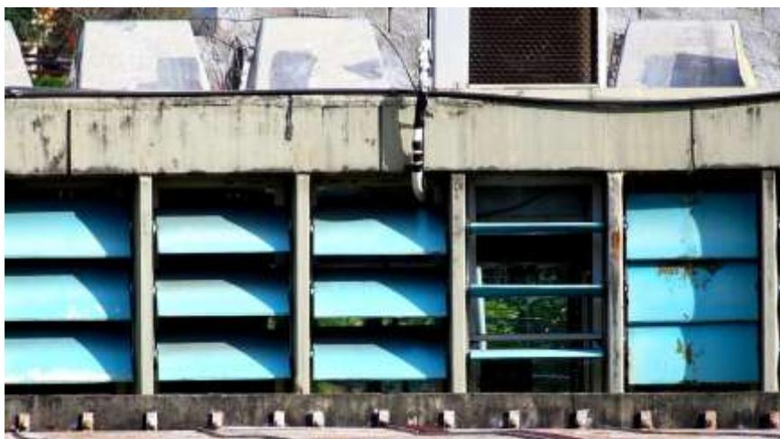
Fig. 443: Vista do sistema de brises móveis da Central de Delegacias e dos escapes das vigas shed acima. Foto: CANTALICE II.
