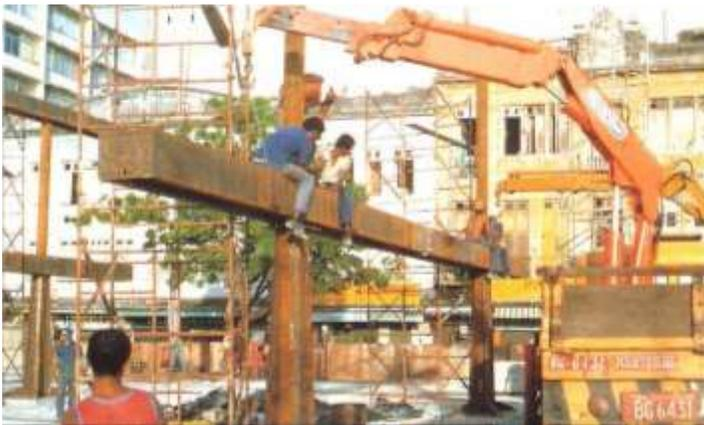
Fig. 427: Vista do processo de assentamento de uma viga principal. Fonte: LATORRACA, 1999, p. 172.
