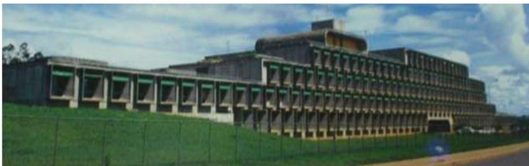
Fig. 403: Vista do hospital e de seu sistema de caixas pré-moldadas que molda a fachada. Fonte: LATORRACA, 1999, p. 48.
