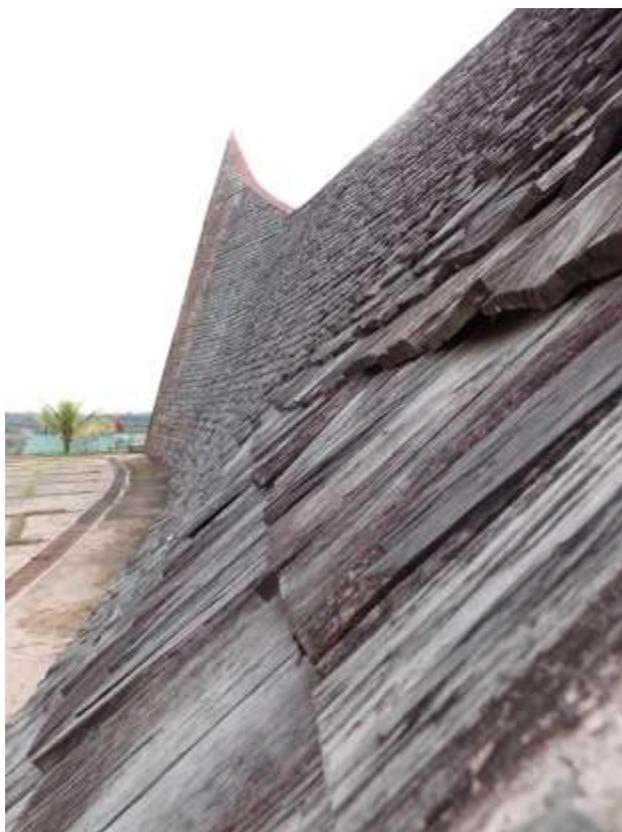
Fig. 334: Vista lateral do Centro Ecumênico demonstrando a torção da cobertura de cavaco que gera uma ponta no final. Foto: CANTALICE II.
