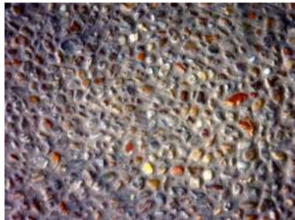
Fig. 172: Detalhe da textura dos seixos rolados gerados no piso, com o seixo incrustado no cimento. Foto: CANTALICE II.
