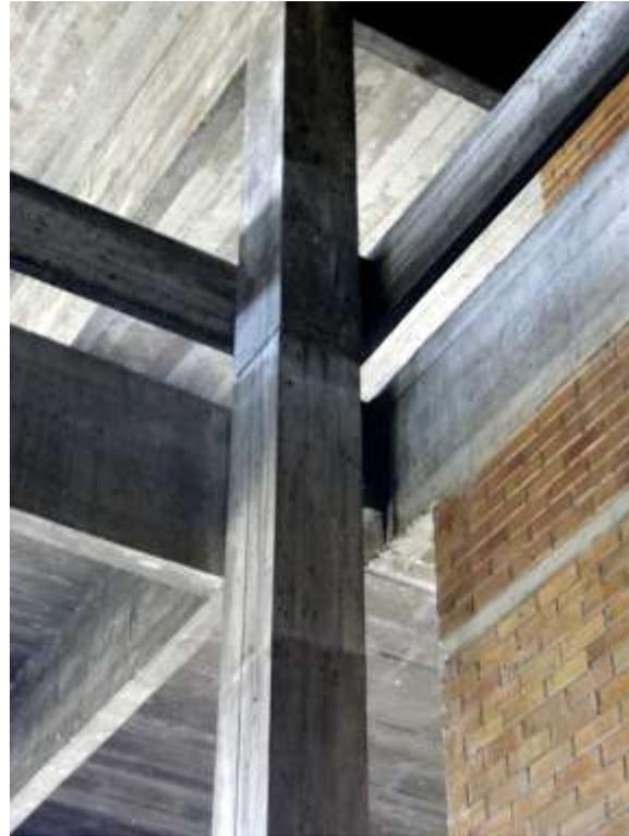
Fig. 170: Detalhe de um pilar e de sua soltura por um friso das vigas de laje, Fórum de Teresina. Foto: CANTALICE II.
