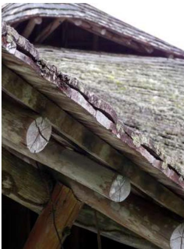
Fig. 335: Vista de um trecho da cobertura de cavaco com um *shed* ao fundo. Foto: CANTALICE II.
