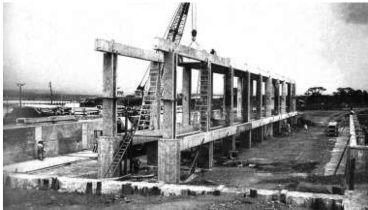
Fig. 393: Construção do Galpão da UnB, vista da galeria de tubulações e calha d'água. Fonte: LATORRACA 1999, p. 35.
