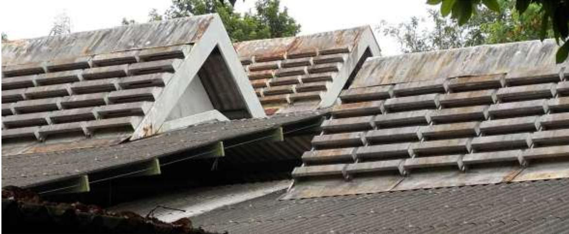
Fig. 294: Detalhe dos *sheds* de escape do ar quente da estrutura metálica. Foto: CANTALICE II.
