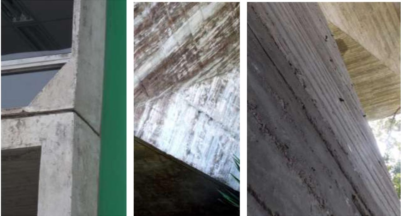
Fig. 384: Textura do concreto em fôrma de placa do prédio administrativo do CAB, 1973. Foto: CANTALICE II.
