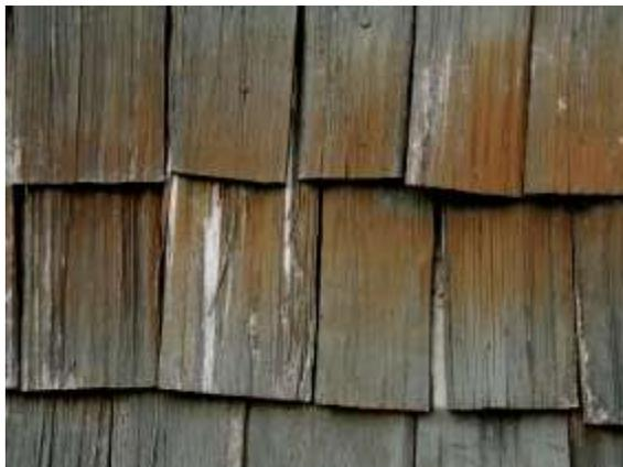
Fig. 234: Vedação em cavaco com corte bruto do Centro Ecumênico de cavaco. Foto: CANTALICE II.
