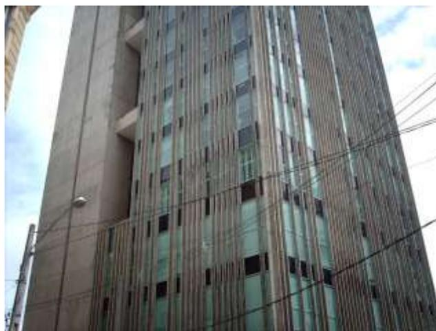
Fig. 109: Recorte do corpo do edifício do BANDEPE. Demonstração do trato com os painéis de concreto, brises de concreto e esquadrias metálicas. Foto: CANTALICE II.
