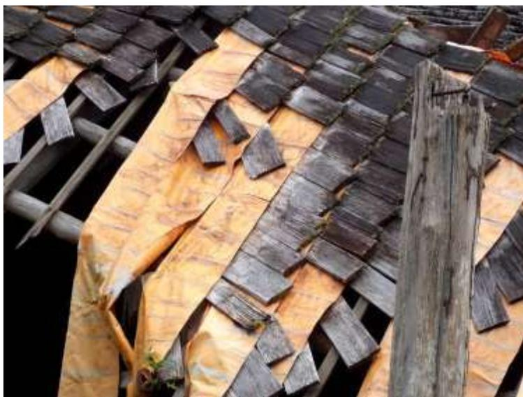
Fig. 341: Trecho desmoronado da cobertura demonstrando o sistema de cavaco e de manta plástica de Balbina. Foto: CANTALICE II.
