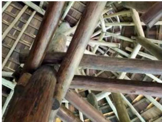
Fig. 332: Vista de um pilar que possui encaixe para viga com uma sucessão de outros apoios. Foto: CANTALICE II.
