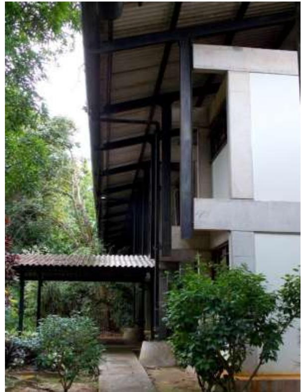
Fig. 350: Vista dos pilares metálicos da cobertura da UFAM e dos blocos independentes em alvenaria e concreto que se desenvolvem abaixo, protegidos do ameno clima amazonense. Foto: CANTALICE II.
