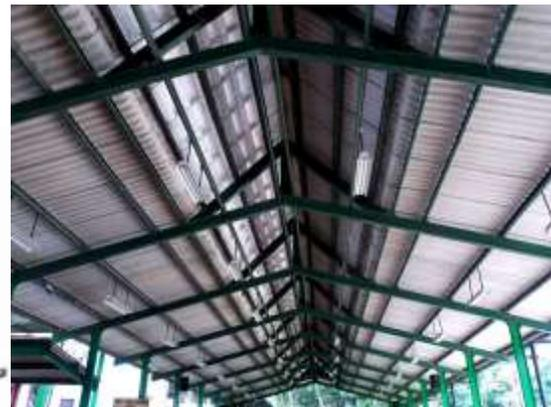
Fig. 296: Vista interna dos *sheds* de escape do ar quente da estrutura metálica. Foto: CANTALICE II.
