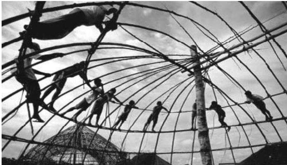
Fig. 320: Construção de uma oca no alto Xingu. Fonte: ESPOSITO, 2007, p. 94.
