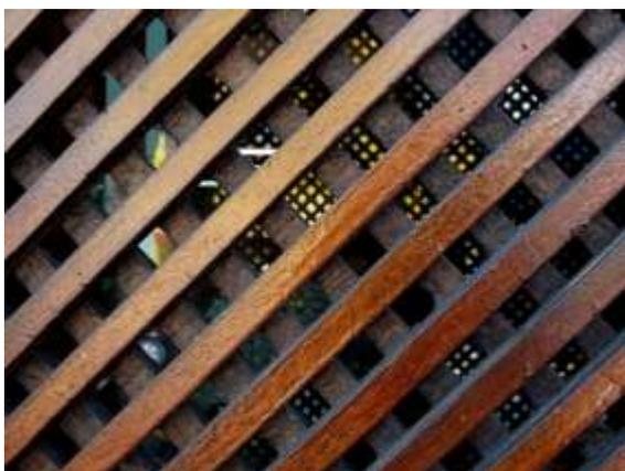
Fig. 236: Sistema de muxarabi de proteção do pano de vidro do BASA. Foto: CANTALICE II.
