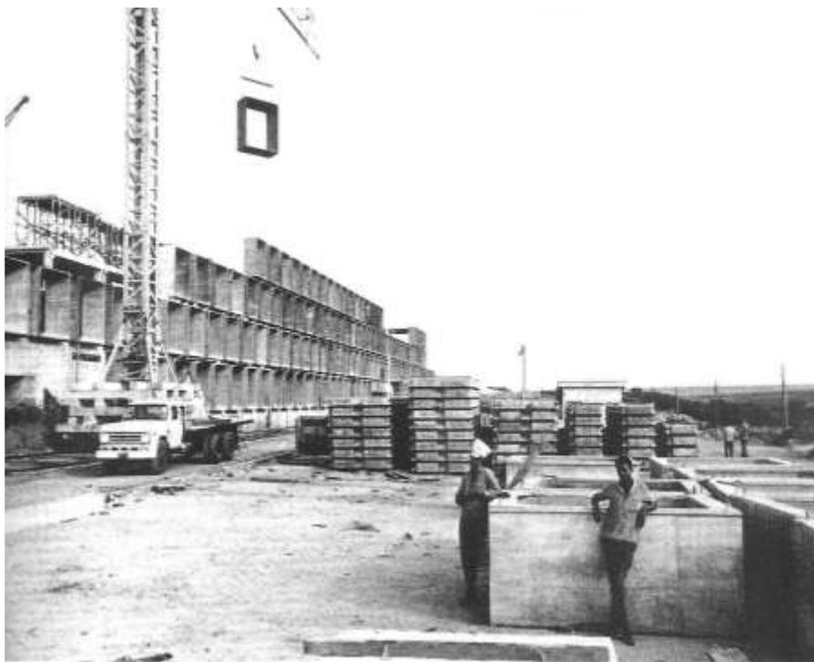
Fig. 402: Vista do hospital com a grua e a fachada em montagem. Fonte: LIMA, 2012, p. 77.
