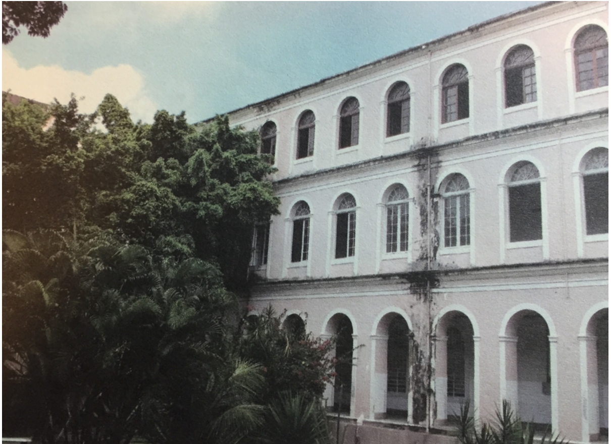
Figura 10 – Detalhe do Pátio Interno do Hospital Pedro II. Predomina a horizontalidade da construção.
