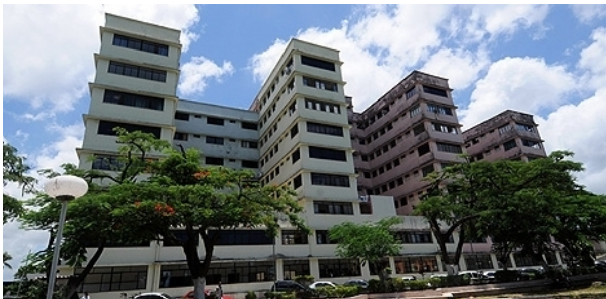
Figura 19 – Hospital Barão de Lucena - Vista Lateral
