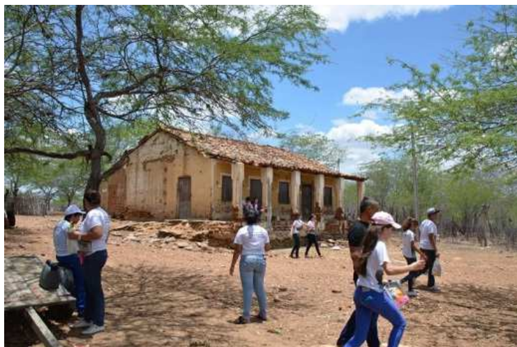
Figura 27 – Casa típica de fazenda abandonada na margem do Riacho Jataúba, afluente do rio Capibaribe em seu alto curso.
