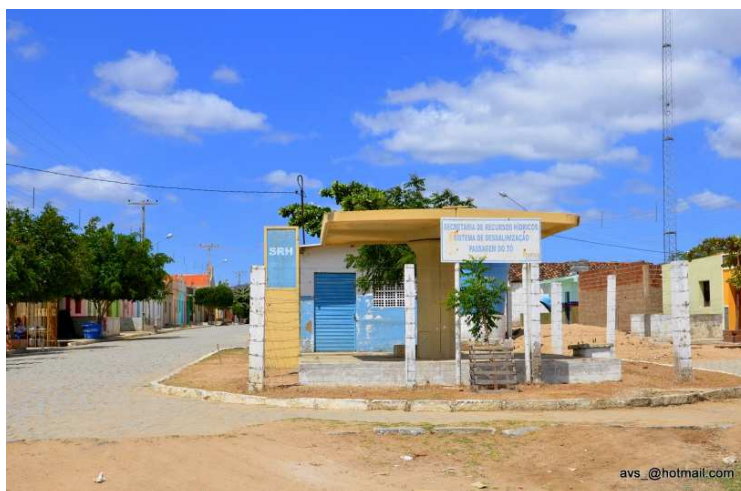
Figura 83 – Estrutura do local do dessalinizador.
