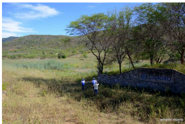
Figura 74 – Lateral da parede do açude Tanquinho com a identificação da instituição responsável pela construção. Ao fundo se vê a área de acumulação totalmente assoreada.
