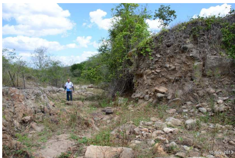
Figura 71 – Vestígios de tentativas antigas de barramento do riacho Muquém-Passagem, com construção em pedra e barro.
