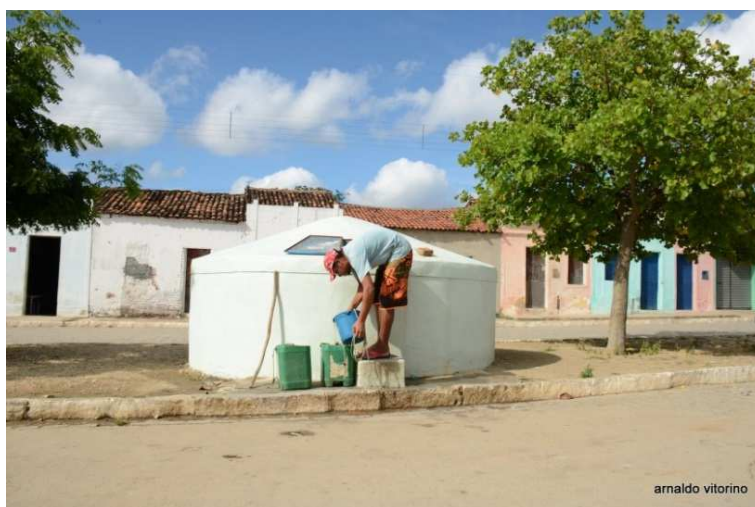
Figura 77 - Cisterna comunitária em Passagem do Tó para abastecimento com carro pipa. Na mesma rua fica o poço com dessalinizador.
