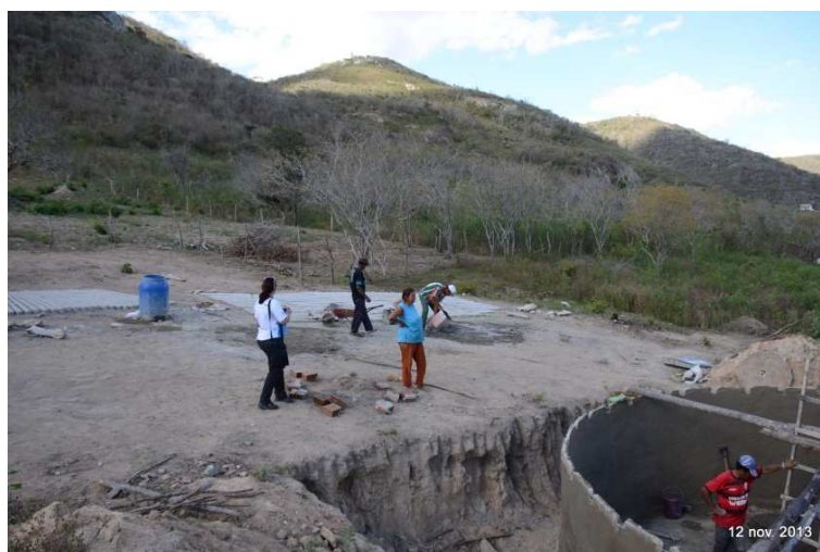
Figura 79 – Cisterna calçadão em construção na comunidade de Muquém.
