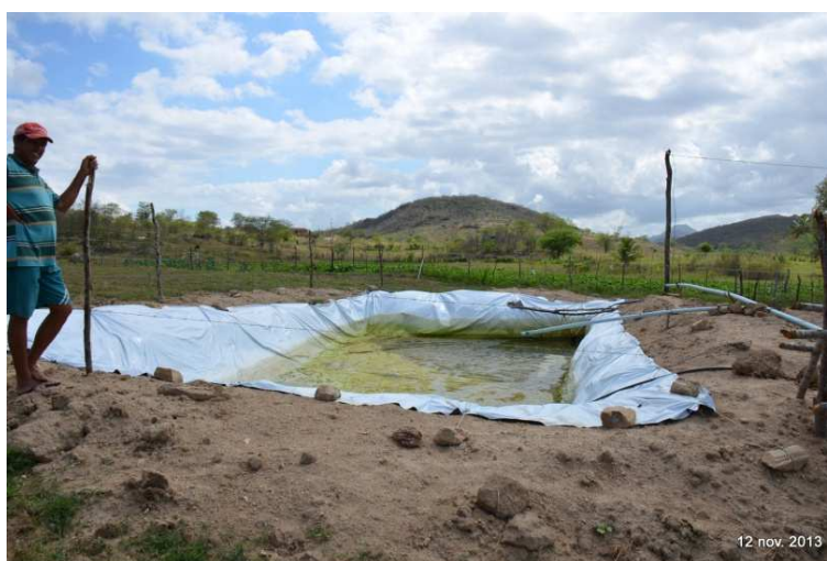
Figura 63 – Tanque cavado e revestido com lona plástica.
