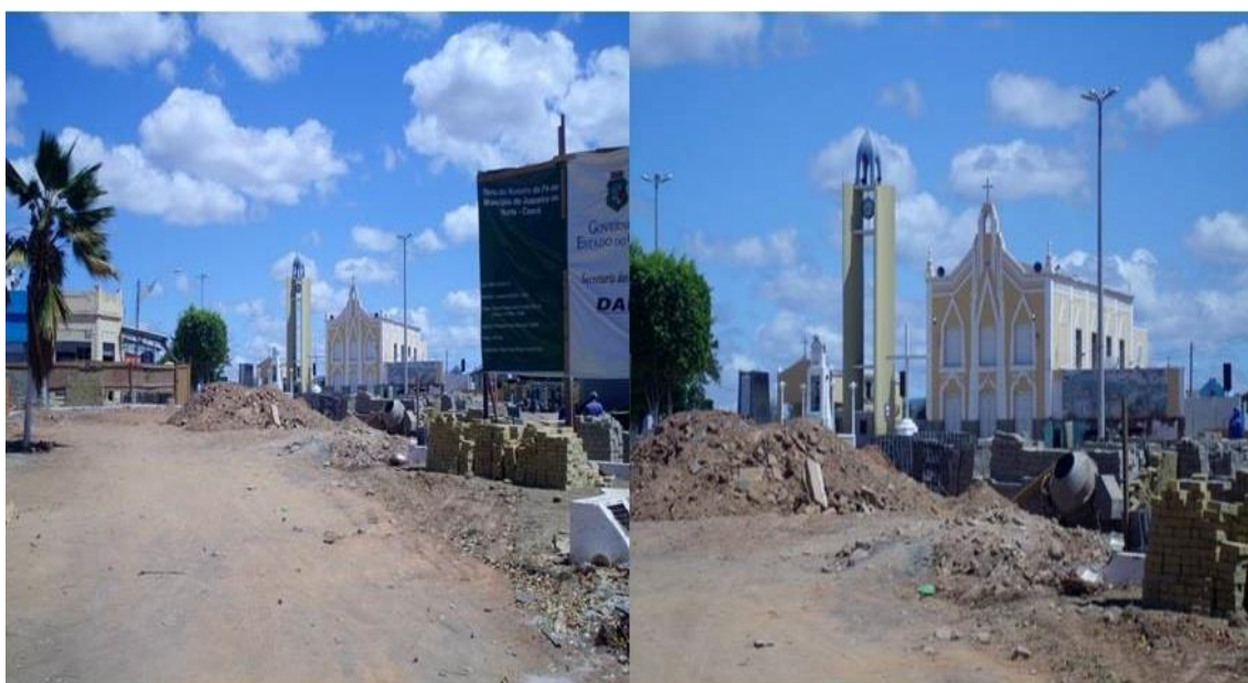
FIGURA 35 – Reformas na centralidade do Socorro
