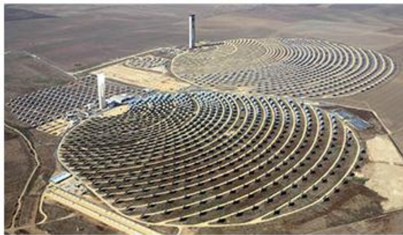
Torre de Potência PS10 (11MW, Espanha).
