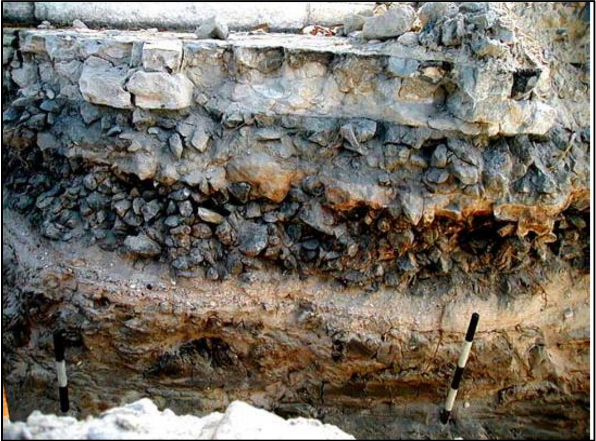
Figura 25 - Sucessivas camadas inseridas para assentamento do revestimento da rua. Fonte: Albuquerque *et al* (2003), p. 22.
