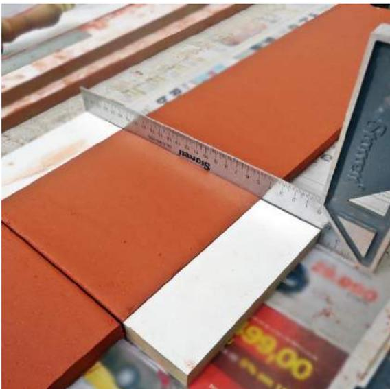
Figura 108 – As peças são medidas e cortadas com o próprio esquadro de aço.
