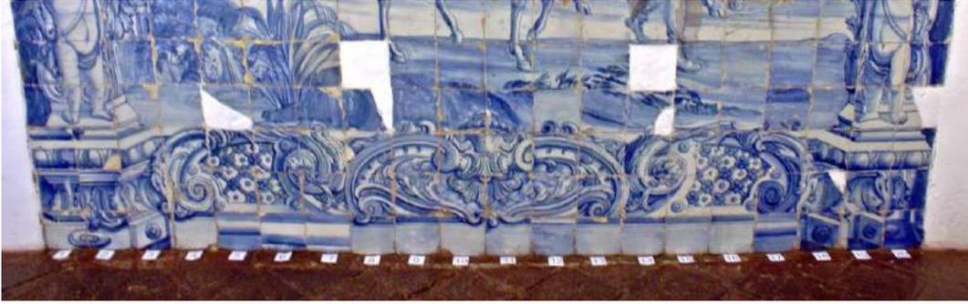
Figura 57 – Identificação numérica das colunas de azulejos no painel “Fuga do Egito”, objetivando maior fluidez na localização dos códigos de cada peça durante o levantamento de danos. Fonte: o autor.
