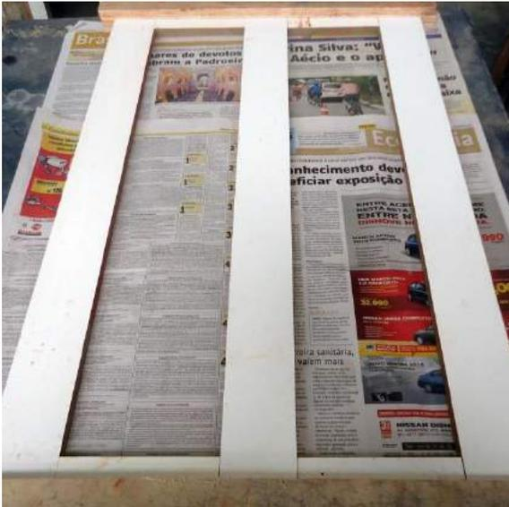
Figura 102 – As ripas de madeira são postas paralelamente, com espaço interno de 15 cm para receber a argila.
