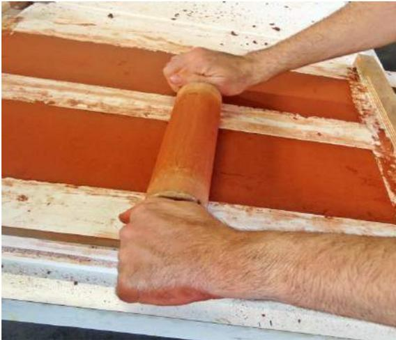
Figura 106 – Finalização com o rolo de madeira, onde as peças possuem a mesma espessura das ripas.
