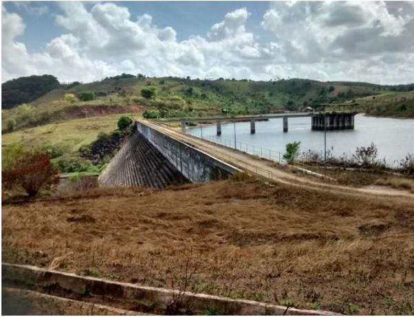
**Figura 18-Tomada de água do reservatório**
