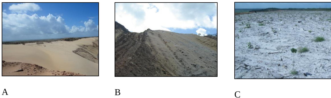
Figura 3. Processo de reconstituição das dunas, Mataraca, PB: A) dunas de areia lavada (rejeito) após a mineração; B) cobertura do rejeito com a camada superficial do solo retirado dos locais antes do processo de mineração; C) plantio de mudas após a reconstituição da duna.
