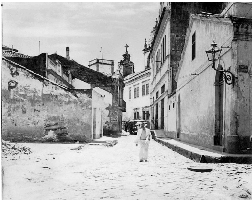
Imagem 12: Demolições no Bairro de Santo Antônio. [194?]. Fotógrafo: Alexandre Berzin. Acervo Museu da Cidade do Recife.
