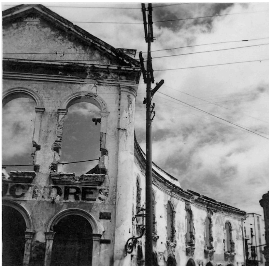
Imagem 11: Demolições no Bairro de Santo Antônio. [194?]. Fotógrafo: Alexandre Berzin. Acervo Museu da Cidade do Recife.
